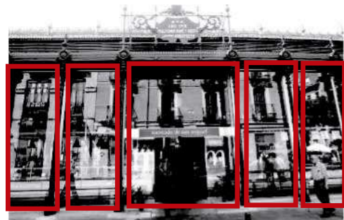
Ilustración 30: Fachada Fuente: Rutas con historia Elaboración: Propia
