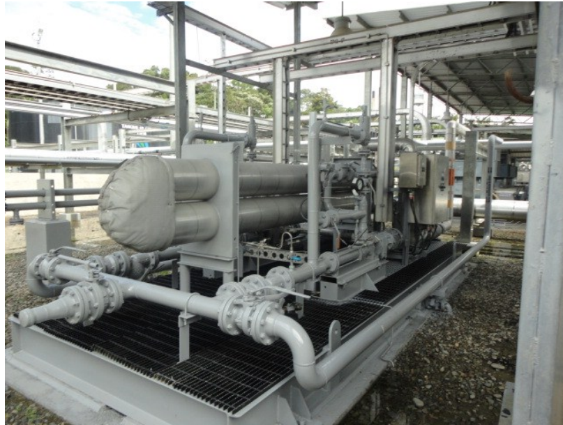
Figura 24. Fotografía de Intercambiador de calor (E-250)
