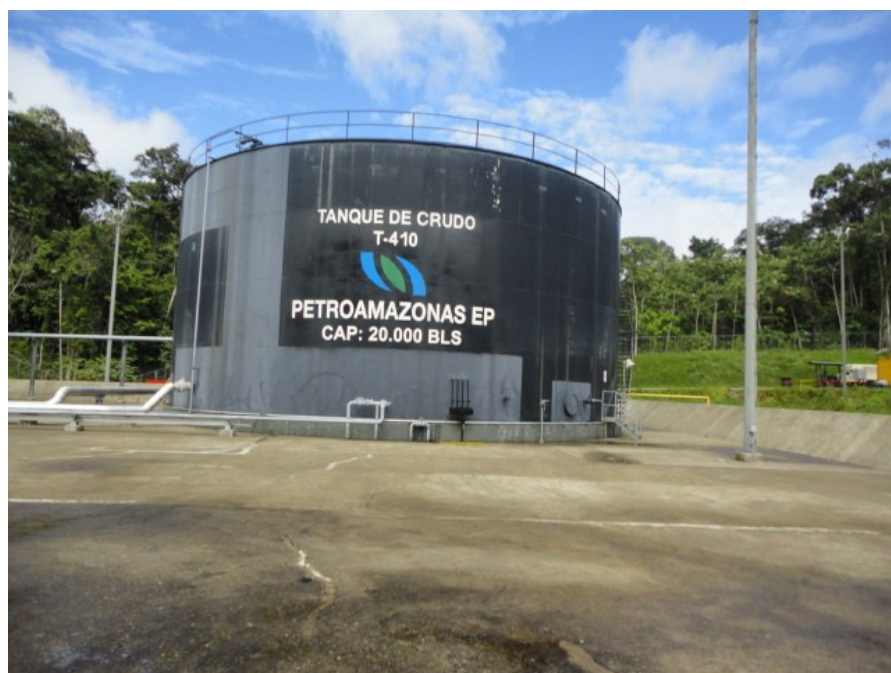
Figura 17. Fotografía de Tanque de almacenamiento de petróleo T-410.
