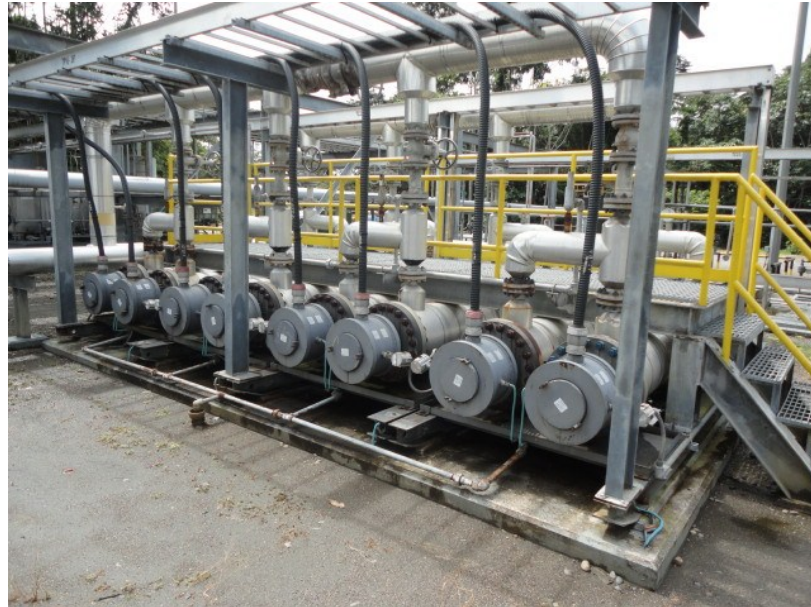
Figura 37. Fotografía de Calentadores Eléctricos (J-220 A/B/C/D/E/F/G/H).
