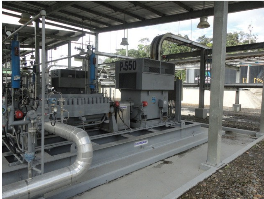
Figura 20. Fotografía de bombas shipping de exportación de petróleo (P-540/550).
