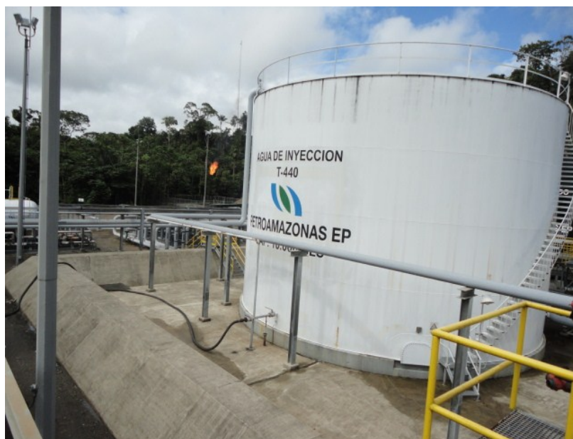
Figura 27. Fotografía de Tanque de Desnatado (T-440).
