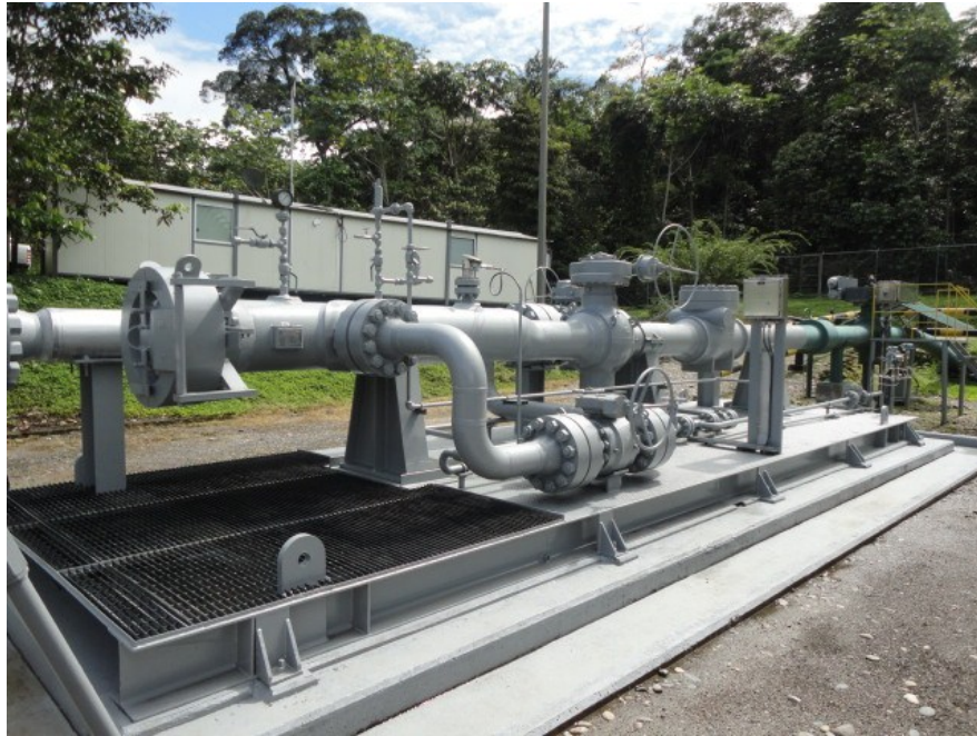
Figura 21. Fotografía de lanzador de “raspadores” de oleoducto Yuralpa - Puerto Napo.
