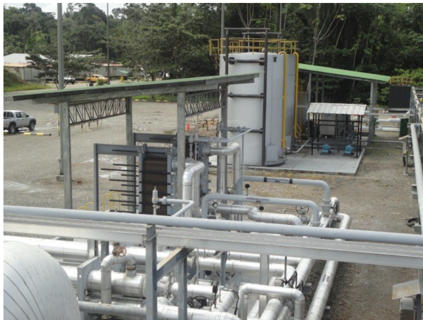
Figura 14. Fotografía de Cross Exchanger E- 280 / 290.
