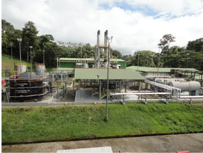
Figura 43. Fotografía de Planta de Generación de Energía Eléctrica (PGP).
