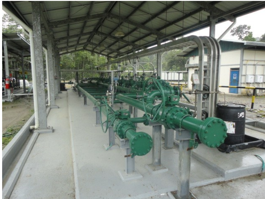
Figura 10. Fotografía de manifold de producción en pad del Bloque 21.
