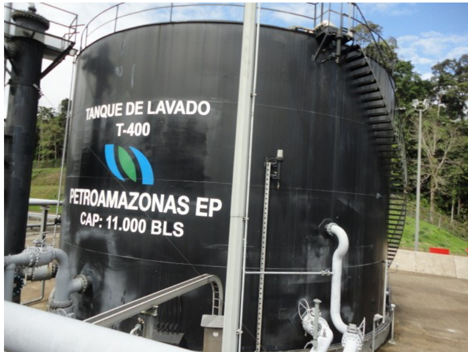
Figura 12. Fotografía de Tanque de lavado T-400
