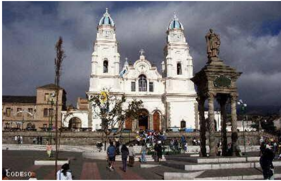
Fotografía No. 2. Iglesia de El Quinche, parque central.
