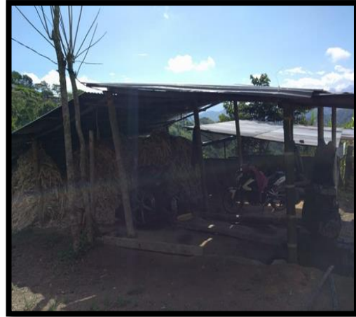
Figura 2. Infraestructura de la panelera 1.
