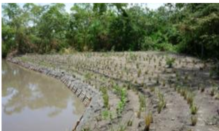
Figura 4 Siembra del pasto vetiver en las riberas del río
