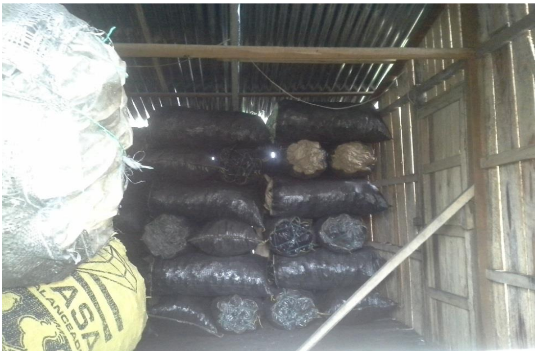
Figura 4. Construcción de la bodega de carbón vegetal
