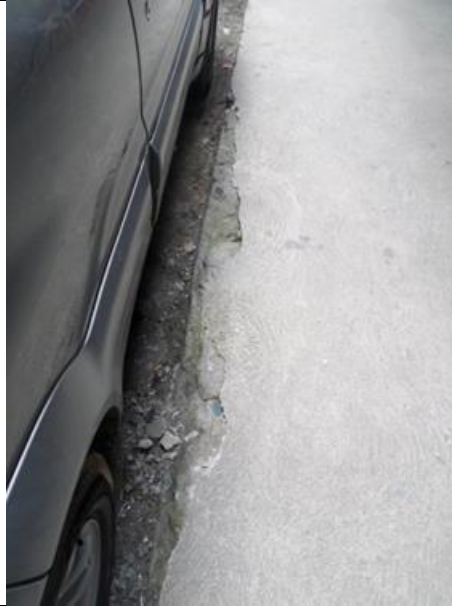
Presencia de vegetación en calles
