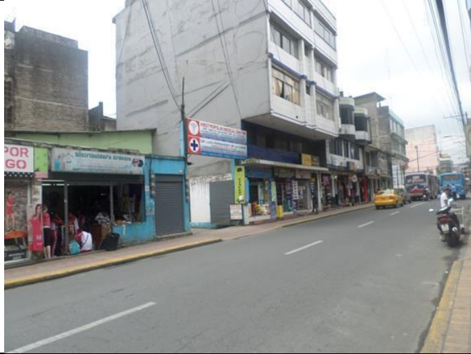
Capa asfáltica con presencia de fisuras
