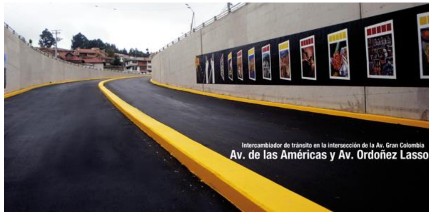
Figura 24. Pavimento en buen estado
