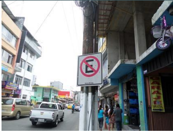
Tendido eléctrico cerca de edificaciones
