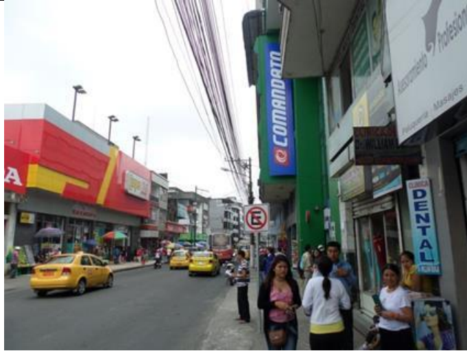
Asfalto con fisuras tipo piel de cocodrilo
