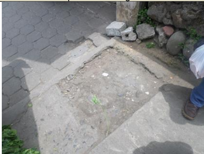
Aceras con presencia de grandes fisuras
