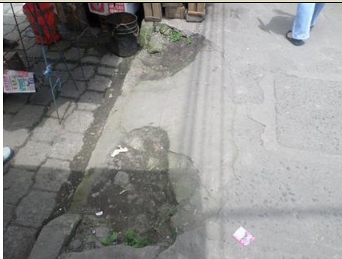
Aceras con presencia de grandes fisuras
