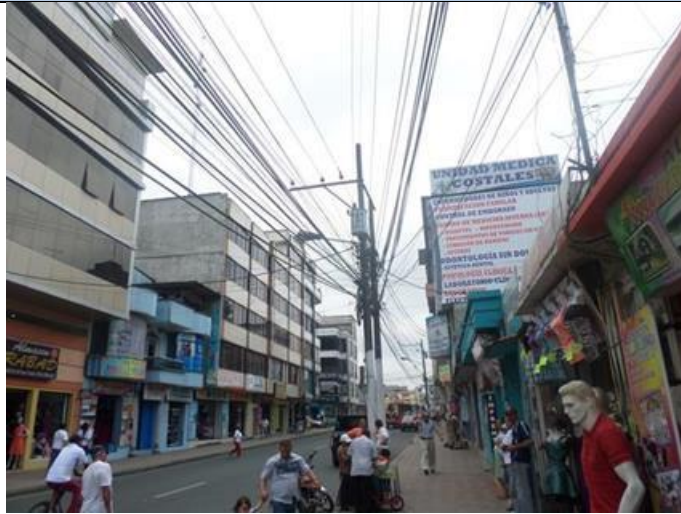
Capa asfáltica con fisura
