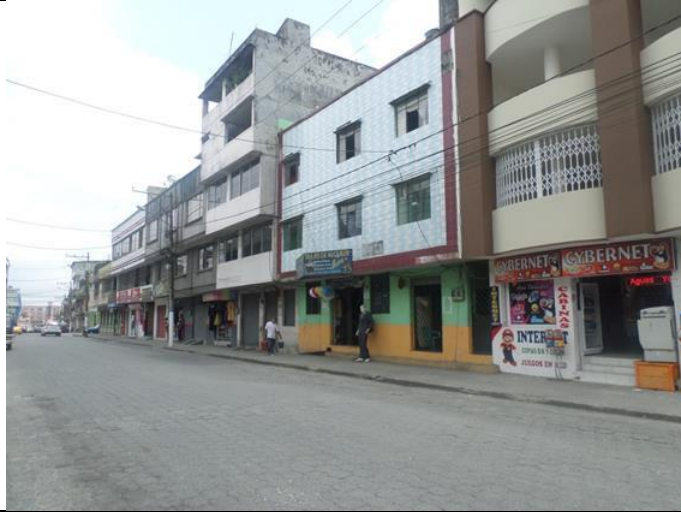
Alcantarillas sin tapas
