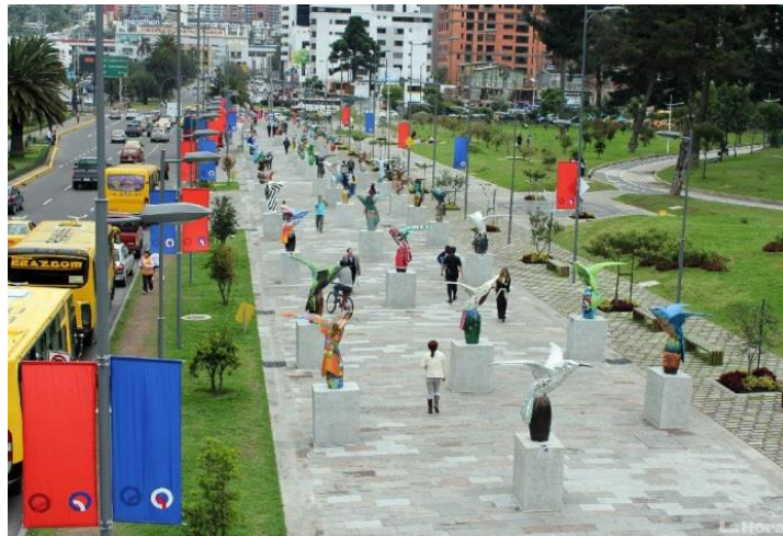
Figura 17. Boulevard de Quito con Soterramiento de Cables Eléctricos (Diario La Hora, 2011)
