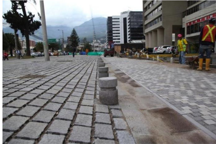
Figura 21. Borde y acera en buen estado (EPMMOP, 2013)
