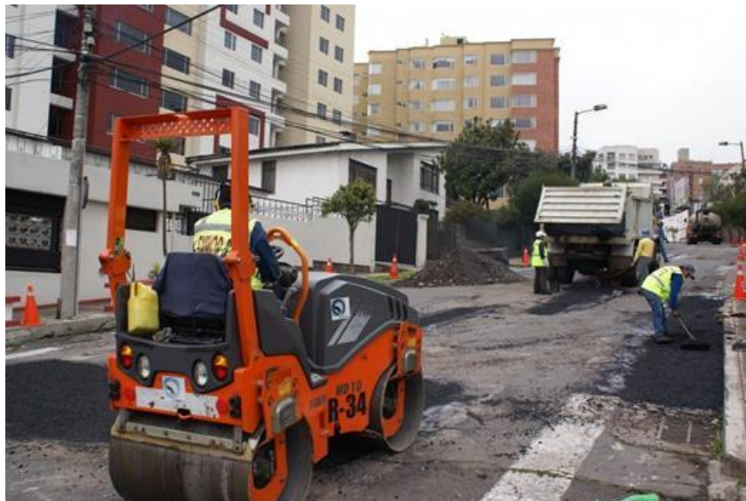
Figura 23. Pavimento en mal estado
