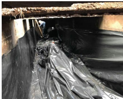
Figura 18. Traslado del biodigestor a la caja de acumulación
