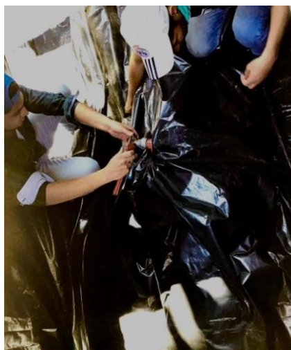
Figura 16. Instalación de la válvula salida
