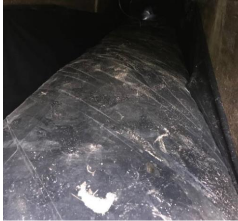
Figura 19. Inflado del biodigestor
