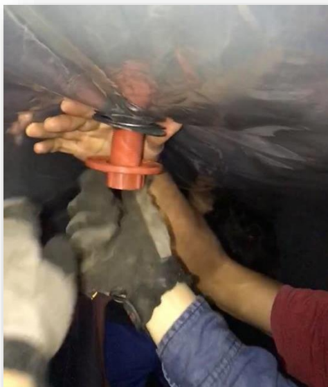
Figura 15. Instalación de la válvula de gas
