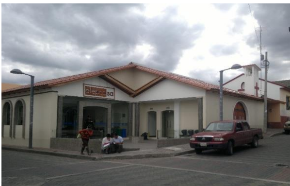
Fotografía 07: Empresa Eléctrica Pujilí (Calle Pichincha y pasaje Bolívar Avilés) Elaborado por: González, Angélica (2015)
