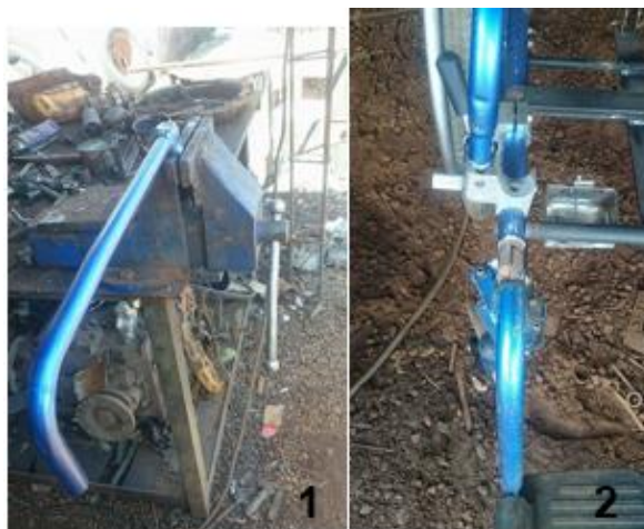
Figura 36. Cortes en los tubos para las articulaciones
