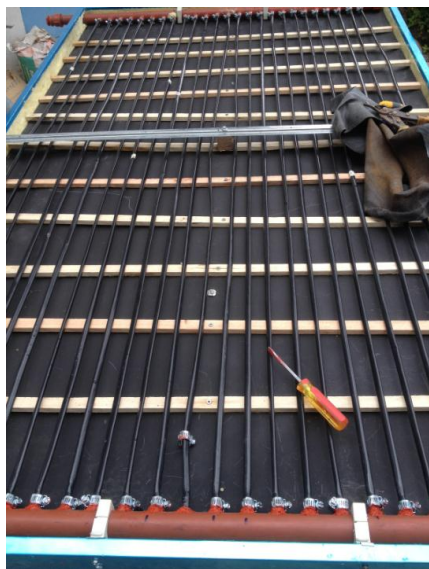
Figura 63. Instalación de acoples manguera y alzas
