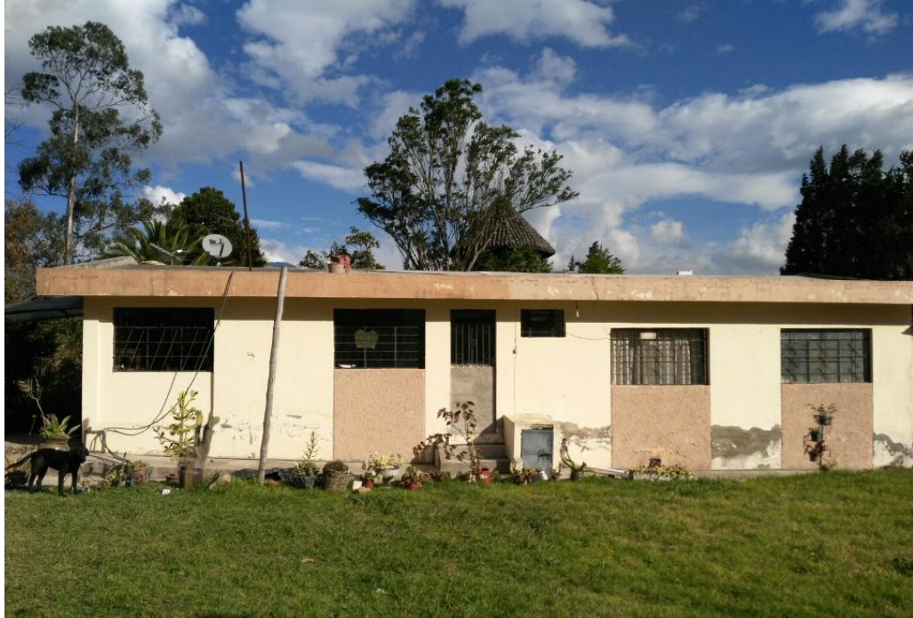
Figura 41. Casa donde se proyecta la instalación del proyecto
