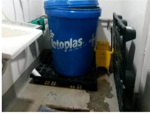
**Figura 16.** Tanque de almacenamiento del agua residual
