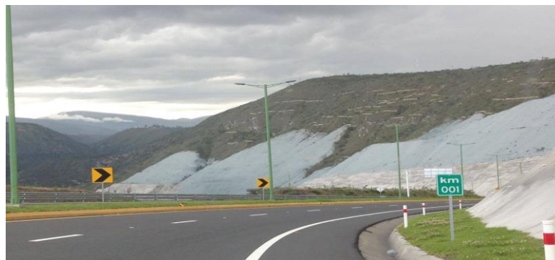
Figura 13. Geomembranas de la Vía Collas
