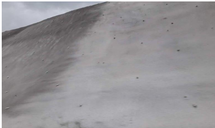
Figura 16. Estabilización de taludes de la Vía Collas
