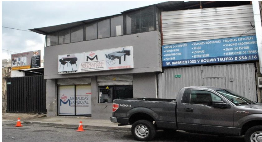
Fachada frontal "Metálicas Sandoval"
