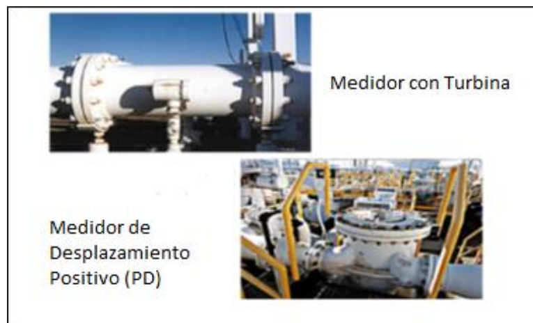
Figura 29. Medidores de Desplazamiento Positivo en una unidad LACT. Fuente: Programa de Entrenamiento para Operaciones de Ductos. (2014).
