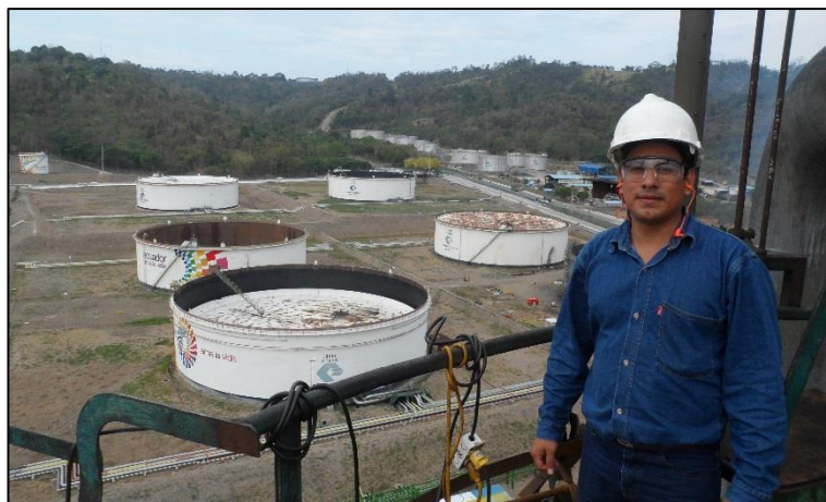
Anexo 3. Tanques de Almacenamiento de la Refinería de Esmeraldas.
