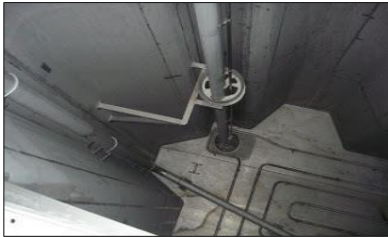
Figura 12. Disposición de la Boca de Campana en el Fondo del Tanque de un Buque Tanque.
