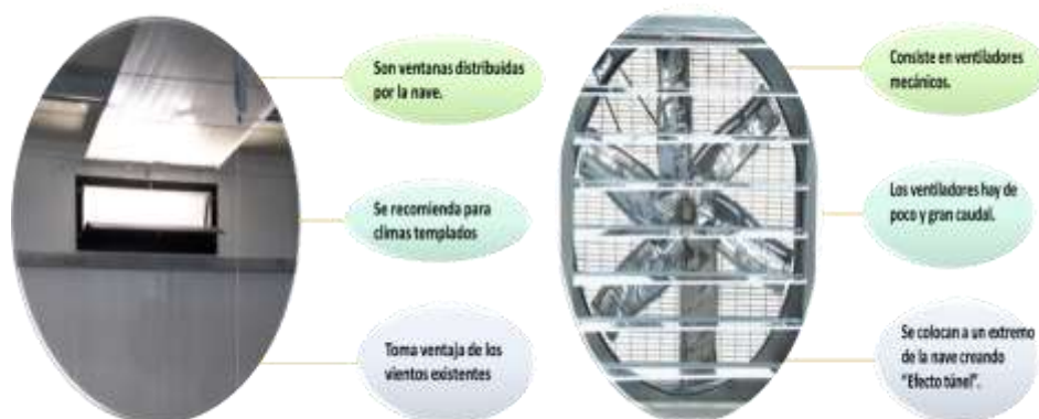
Figura 3. Sistema de ventilación
