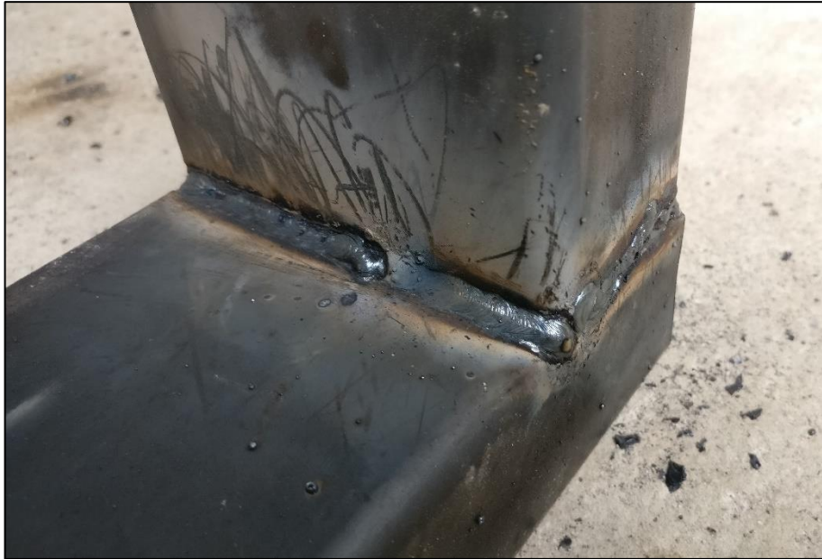
Figura 15. Suelda de estructura Fuente: Autor
