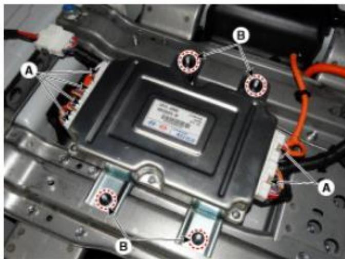
Figura 49. Desmontaje del BMS. (Hyundai Motor Co., 2017)
