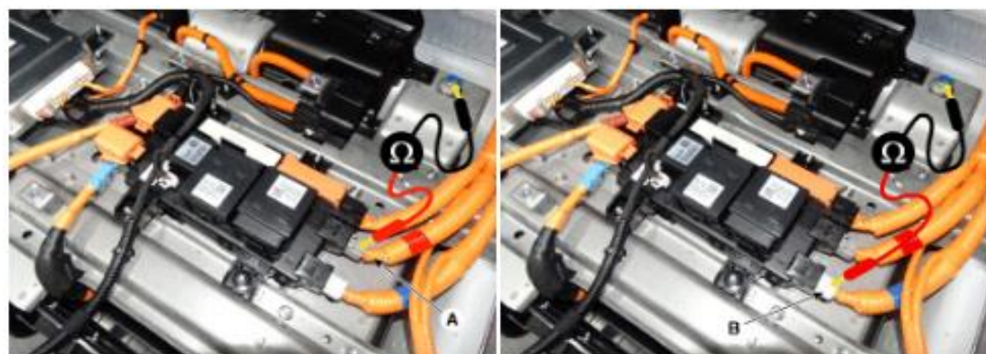
Figura 40. Proceso de medición de resistencia del aislamiento inversor con multímetro. (Hyundai Motor Co., 2017)
