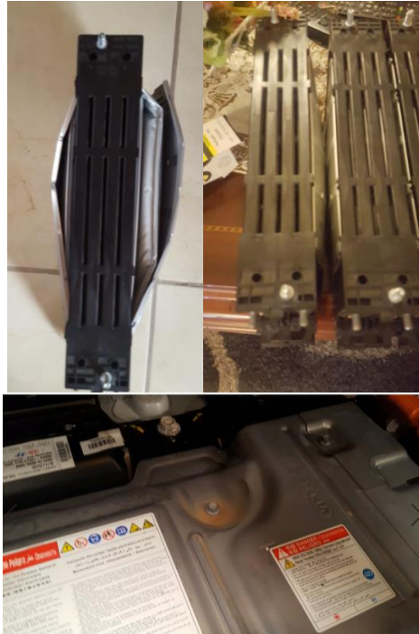
Figura 92. Inspección estado físico batería.
