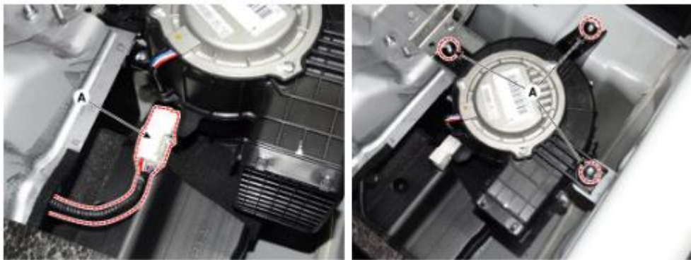
Figura 46. Desmontaje ventilador batería. (Hyundai Motor Co., 2017)
