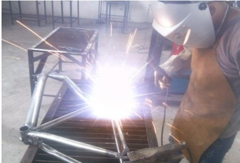
Figura 44. Soldadura de la estructura principal Fuente: Autor
