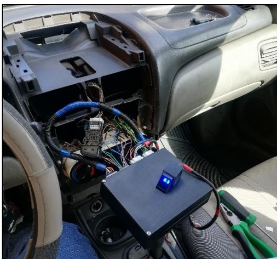
Figura 55. Montaje del dispositivo concluido (Autor)
