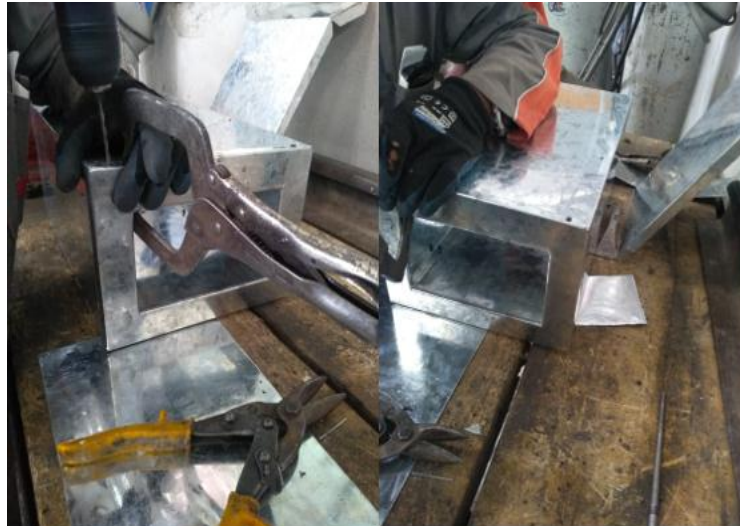
Figura 20. Construcción de la Base Metálica
