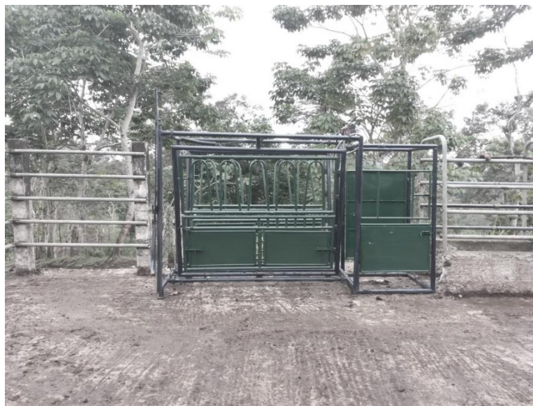
Figura 42. Colocación de las puertas
