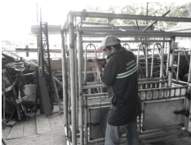
Figura 35. Instalación de puertas
