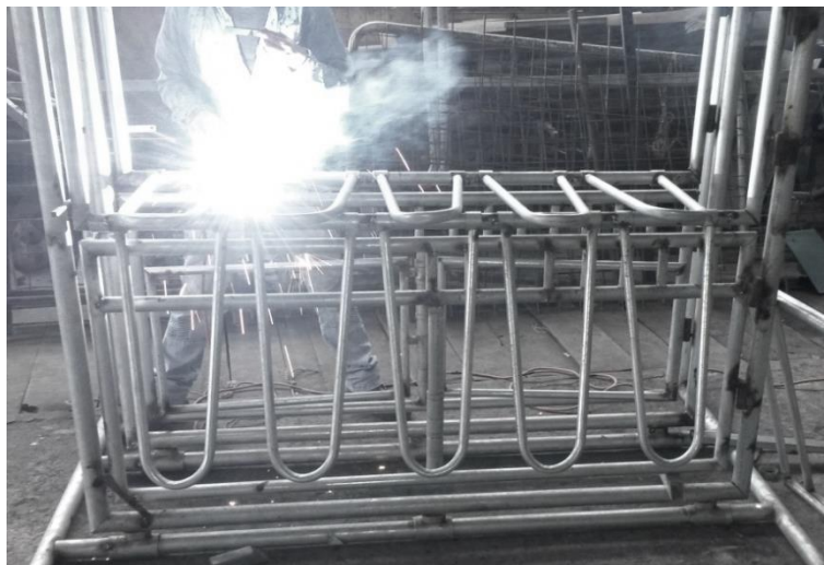
Figura 32. Construcción de puertas volcables
