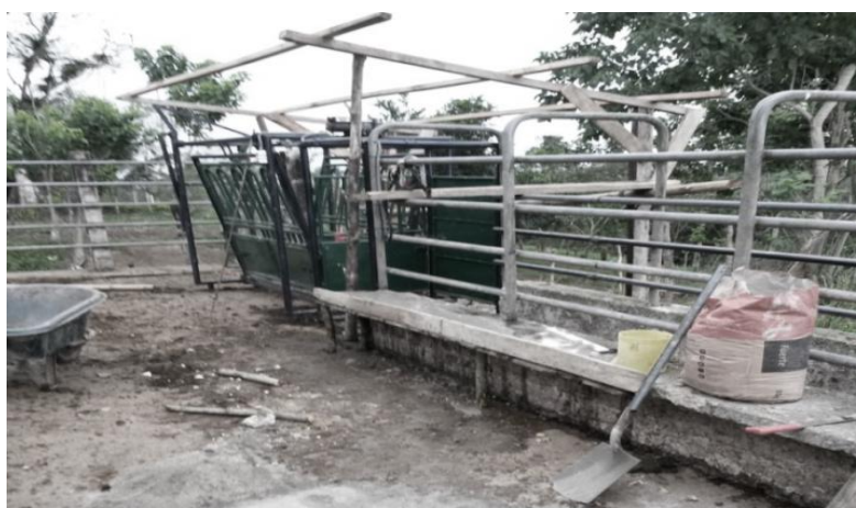
Figura 43. Cubierta del brete
