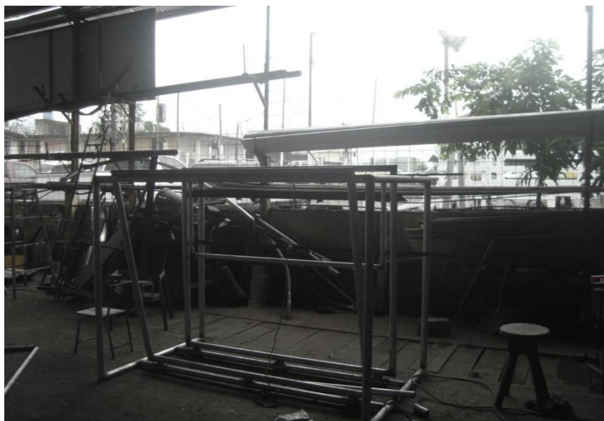
Figura 30. Terminación del marco de sujeción
