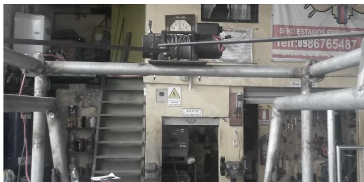
Figura 39. Colocación del cabrestante
