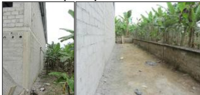
Figura N° 4.148. Vista lado izquierdo y derecho de subestación
