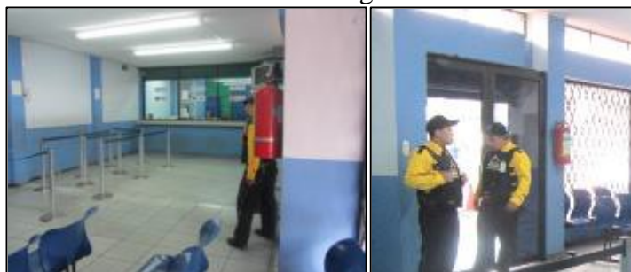
Figura N° 4.264. Extintor en agencia
