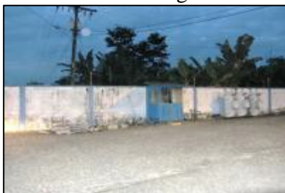
Figura N° 4.205. Garita de ingreso
