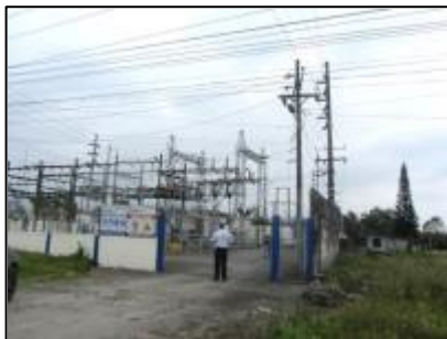
Figura N° 4.99. Vista lado derecho
