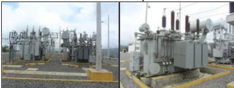
Figura N° 4.75. Transformadores de potencia
