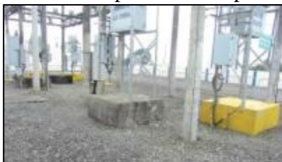
Figura N° 4.110. Bases con pernos sobre piso
