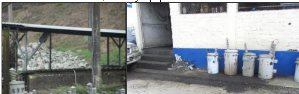
Figura N° 4.26. Desechos, basura y equipos fuera de servicio
