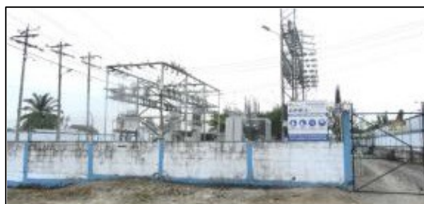
Figura N° 4.32. Vista exterior de la subestación
