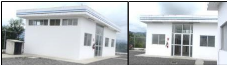
Figura N° 4.78. Vista exterior de sala control
