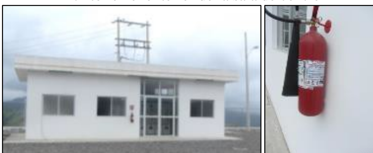
Figura N° 4.81. Extintor en el exterior de la sala de control
