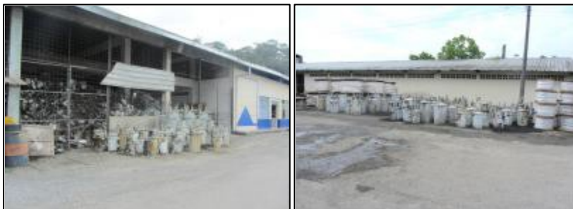
Figura N° 4.21. Almacenamiento de transformadores de distribución
