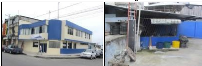
Figura N° 4.271. Vista exterior de bodega
