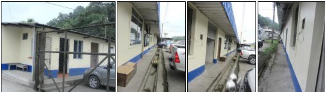
Figura N° 4.7. Vista exterior de oficinas
