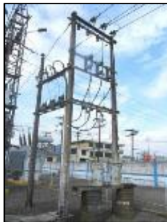
Figura N° 4.138. Transformador auxiliar
