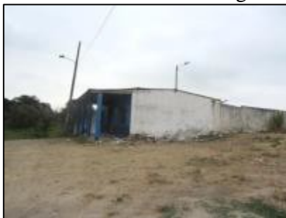
Figura N° 4.284. Vista exterior de bodega
