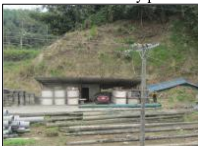
Figura N° 4.24. Bobinas de cables y postes
