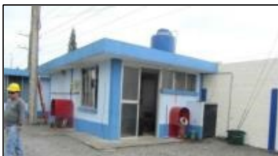
Figura N° 4.114. Extintor en la subestación
