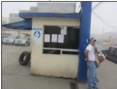
Figura N° 4.250. Garita de ingreso de vehiculos
