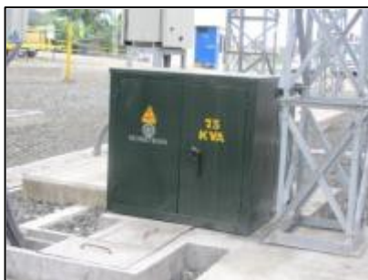
Figura N° 4.203. Transformador auxiliar
