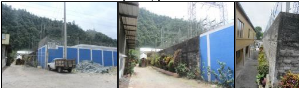
Figura N° 4.55. Vista lado izquierdo y posterior viviendas
