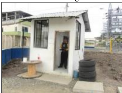
Figura N° 4.193. Garita de ingreso
