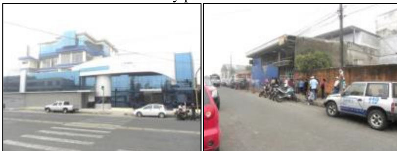
Figura N° 4.233. Vista frontal y posterior del edificio
