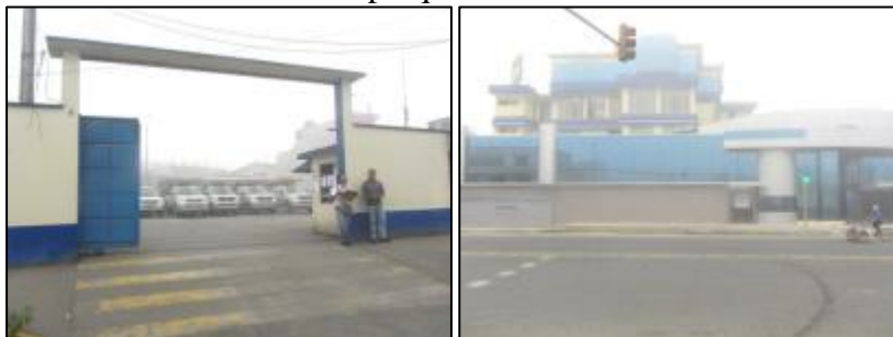
Figura N° 4.249. Patio de parqueo de vehículos
