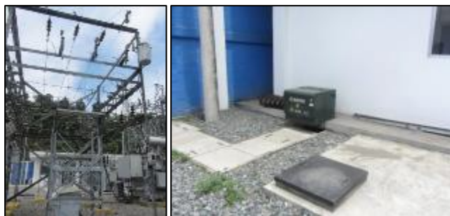
Figura N° 4.68. Transformadores auxiliares
