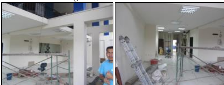
Figura N° 4.258. Agencia en remodelación
