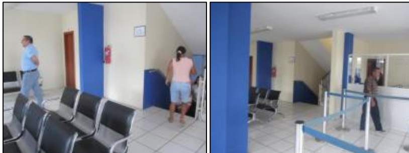
Figura N° 4.274. Extintor sin señalización
