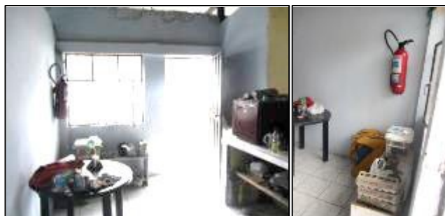
Figura N° 4.231. Extintor en oficina
