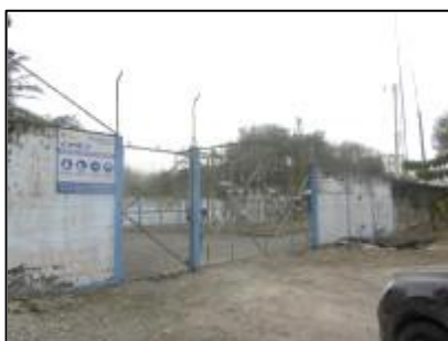
Figura N° 4.218. Vista exterior de la subestación
