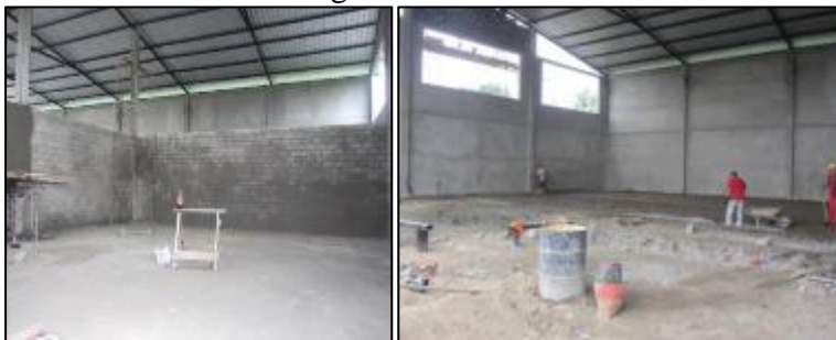
Figura N° 4.159. Bodega en construcción
