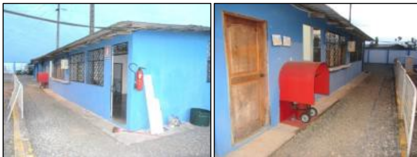
Figura N° 4.215. Extintores en la subestación
