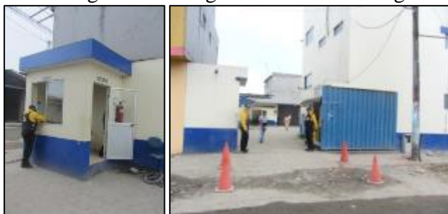
Figura N° 4.256. Garita / guardia de seguridad / extintor en garita
