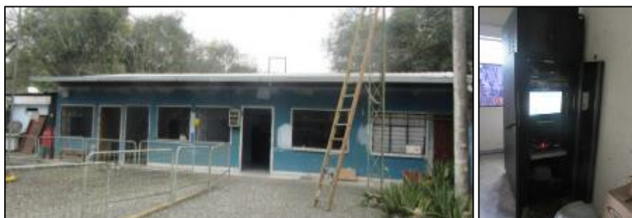
Figura N° 4.228. Sala de control
