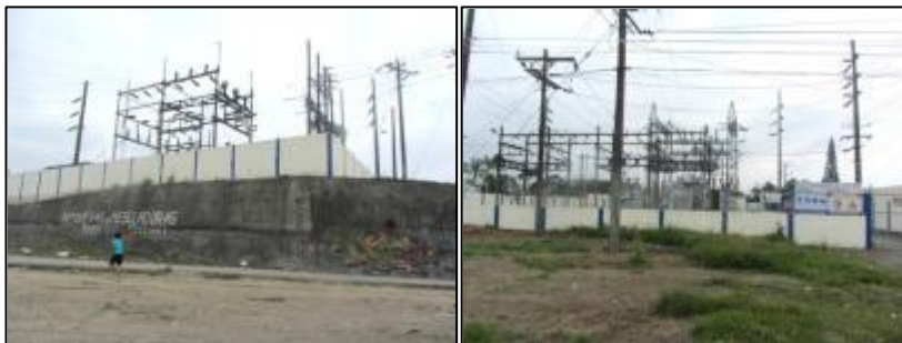
Figura N° 4.98. Vista exterior de la subestación
