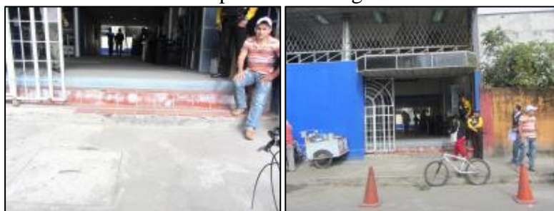
Figura N° 4.234. Vista posterior de ingreso
