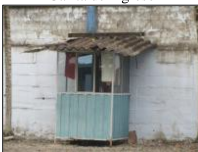
Figura N° 4.220. Garita de ingreso
