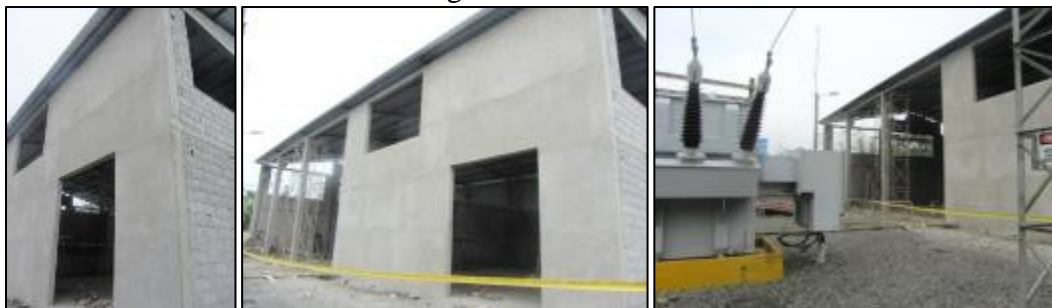
Figura N° 4.158. Bodega en construcción
