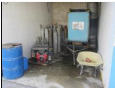
Figura N° 4.1.40. Almacenamiento de cilindros
