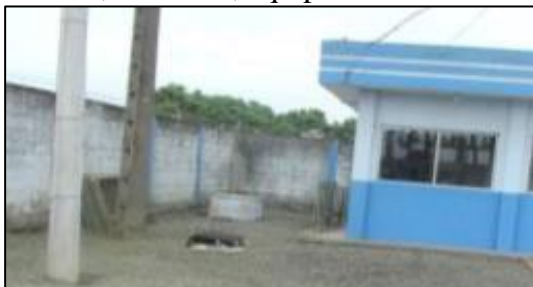
Figura N° 4.95. Basura, desechos, equipos en mal estado
