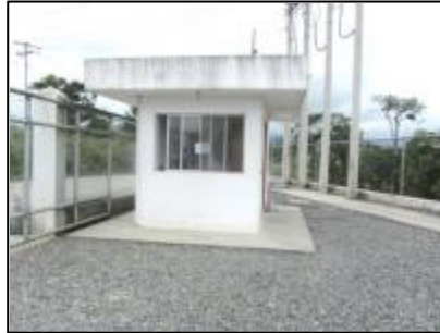
Figura N° 4.72. Garita de ingreso
