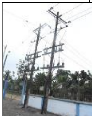
Figura N° 4.153. Salida de alimentadoras a postes
