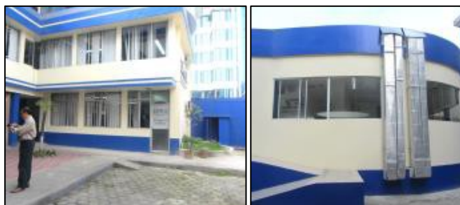
Figura N° 4.236. Vista exterior de oficinas
