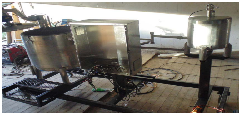
Figura N. 75 Tablero de Control
