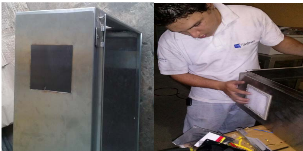
Figura N. 76 Instalación de filtros
