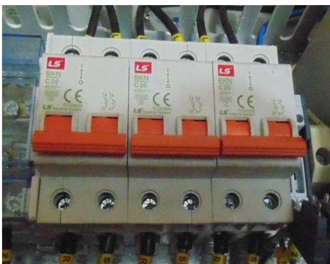
Figura N. 48 Breakers secundarios
