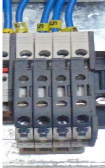
Figura N. 57 Borneras portafusibles LEGRAND
