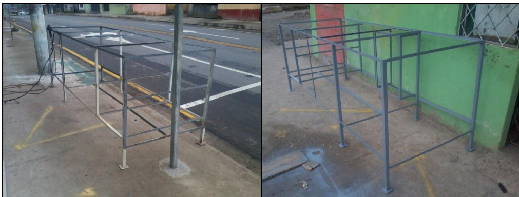
Gráfico N° 4.18 Reconstrucción de la mesa de trabajo
