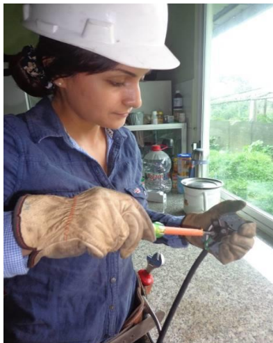
Figura 4. 6. Proceso de Instalación interna en la vivienda
