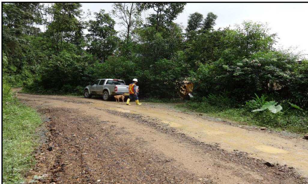
Figura 4.6. Acceso hacia la estructura N° 03
