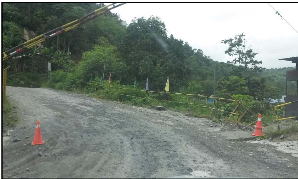
Figura 4.41. Acceso hacia las estructuras N° 28
