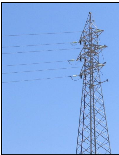
Figura 2.31. Estructura de fin de línea
