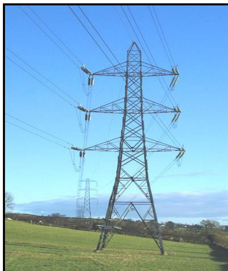
Figura 2.30. Estructura de ángulo
