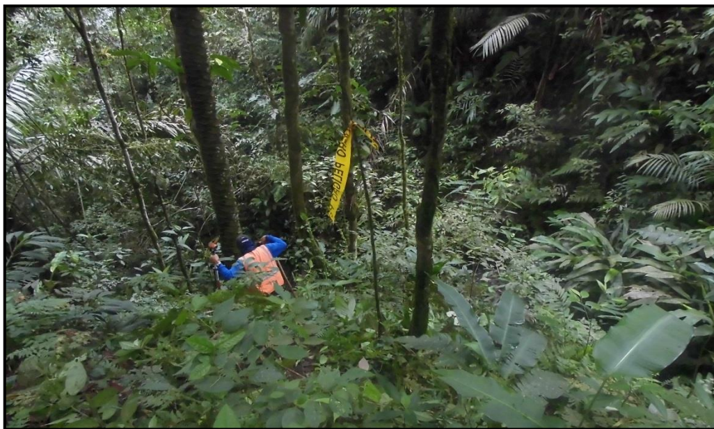
Figura 4.40. Ubicación de la estructura N° 27
