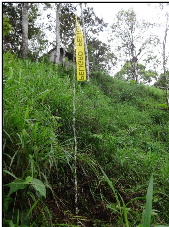
Figura 4.11. Ubicación de la estructura N° 06
