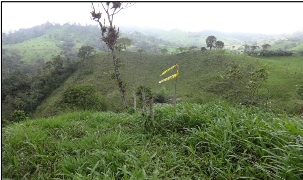
Figura 4.24. Ubicación de la estructura N° 14
