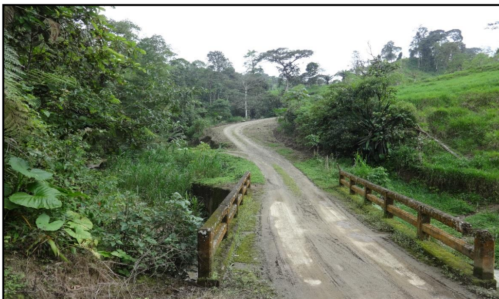
Figura 4.21. Acceso hacia la estructura N° 13
