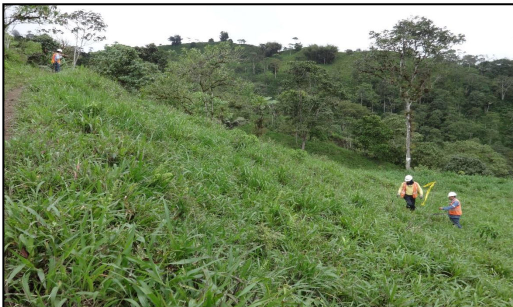
Figura 4.25. Ubicación de la estructura N° 15
