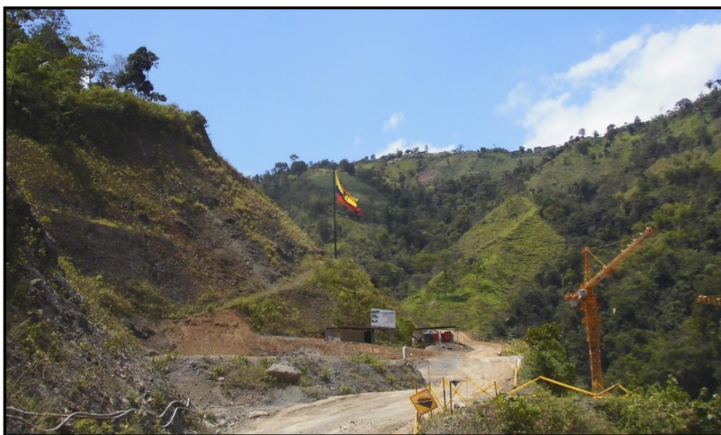
Figura 4.2. Acceso hacia la estructura N° 01
