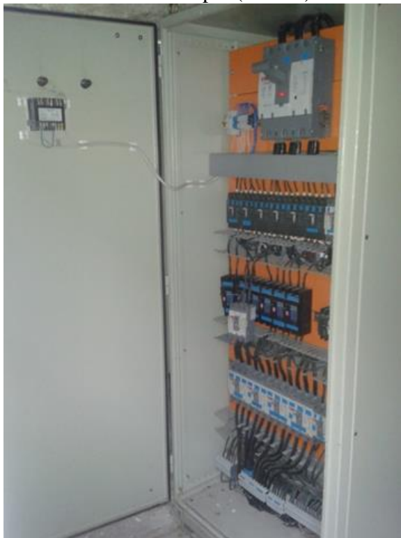
Figura N° 3.20 Tablero de Distribución Principal (abierto) - Transformador 2
