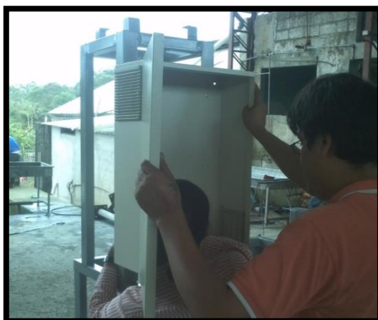
Gráfico N° 5.10 Colocación del tablero eléctrico
