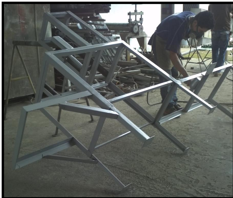
Gráfico N° 5.9 Pintura de la estructura
