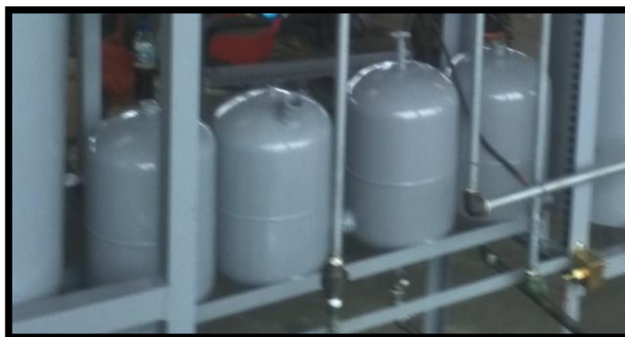
Gráfico N° 5.3 Tanque de purgas
