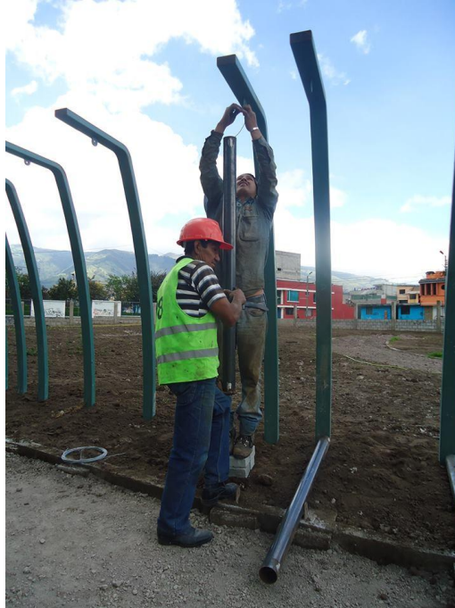
Foto 9 Montaje Proceso de montaje de "Valla con música" (Juan Francisco Segovia, 2013)
