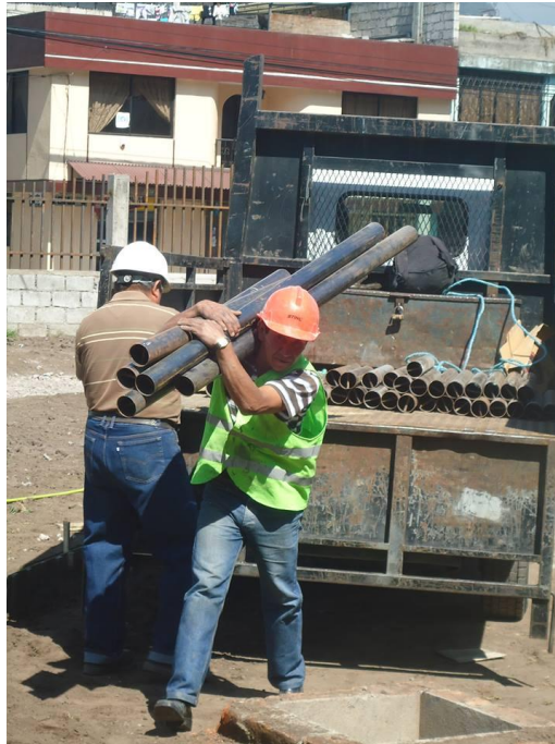
Foto 7 Montaje Proceso de montaje de "Valla con música" (Juan Francisco Segovia, 2013)
