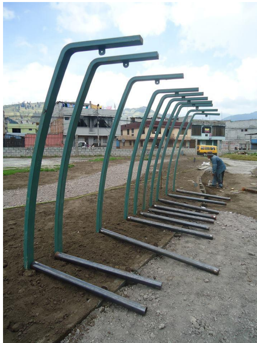
Foto 8 Montaje Proceso de montaje de "Valla con música" (Juan Francisco Segovia, 2013)
