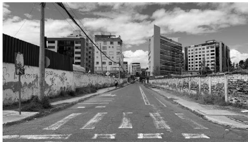
Imagen 1: Falta de permeabilidad. Elaboración propia.
