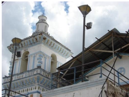
Figura 4: Antigua iglesia de Puéllaro, actualmente en refacción, 2016
