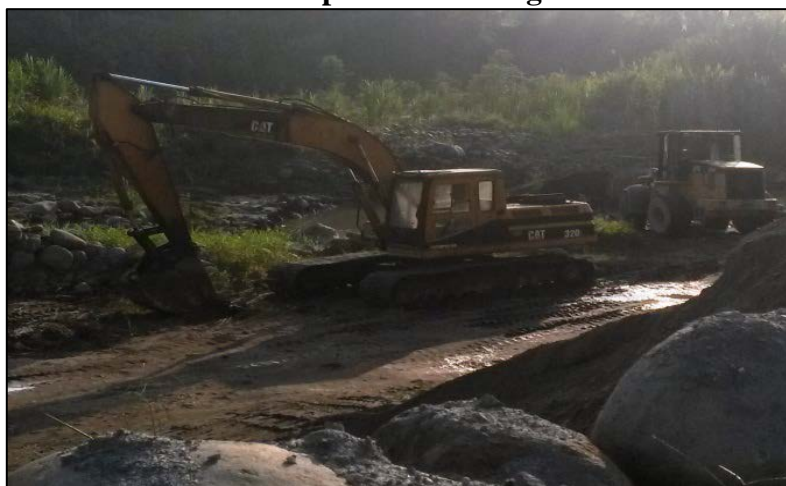
Imagen N° 5 Destape de Sobrecarga
