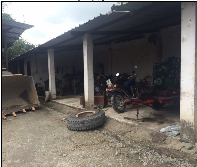
Imagen N° 2 Instalaciones de garaje, patio de mantenimiento
