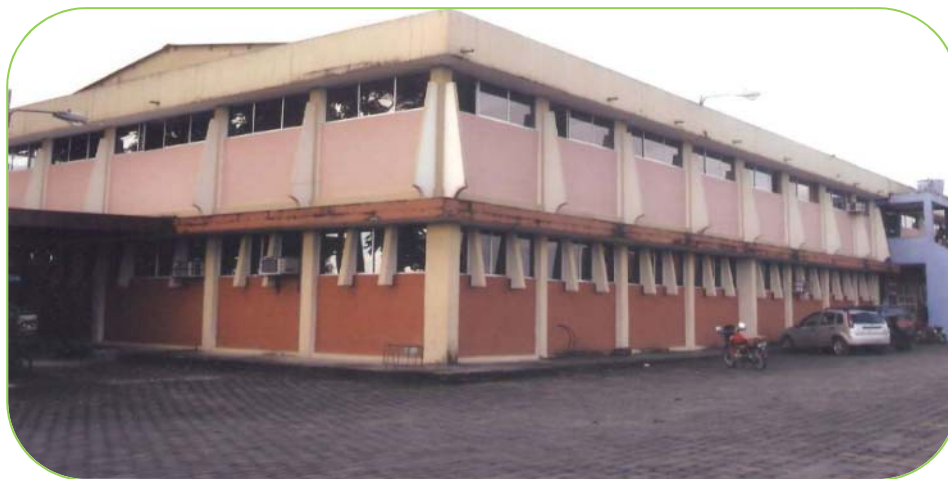
FOTO N° 12 LA “ULEAM”, CAMPUS EL CARMEN
