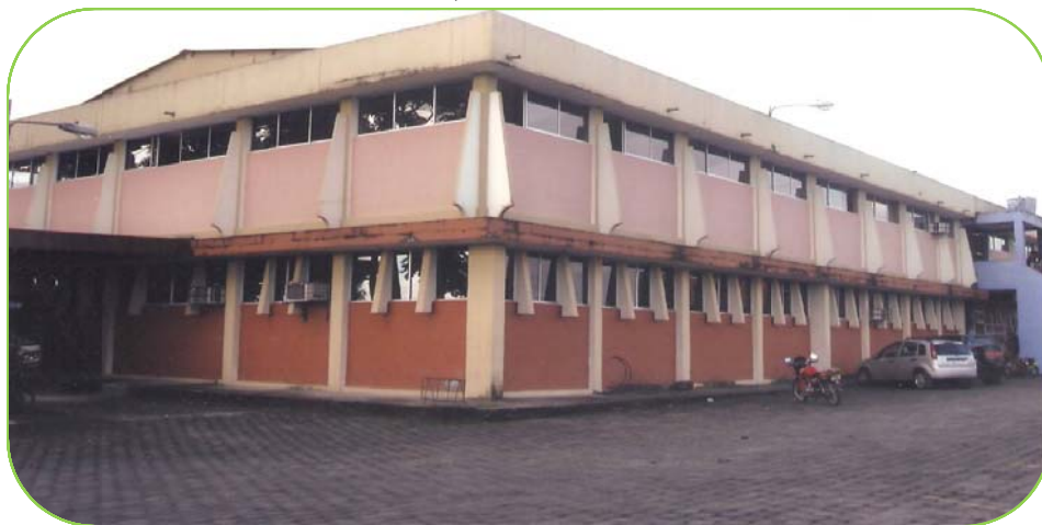
FOTO N° 12 LA “ULEAM”, CAMPUS EL CARMEN
