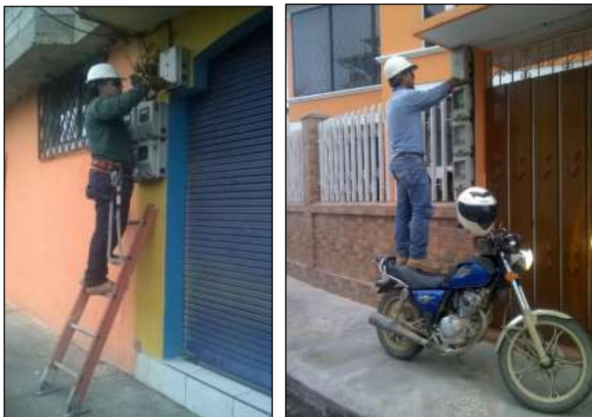
Figura 4.9 Trabajo a distinto nivel
