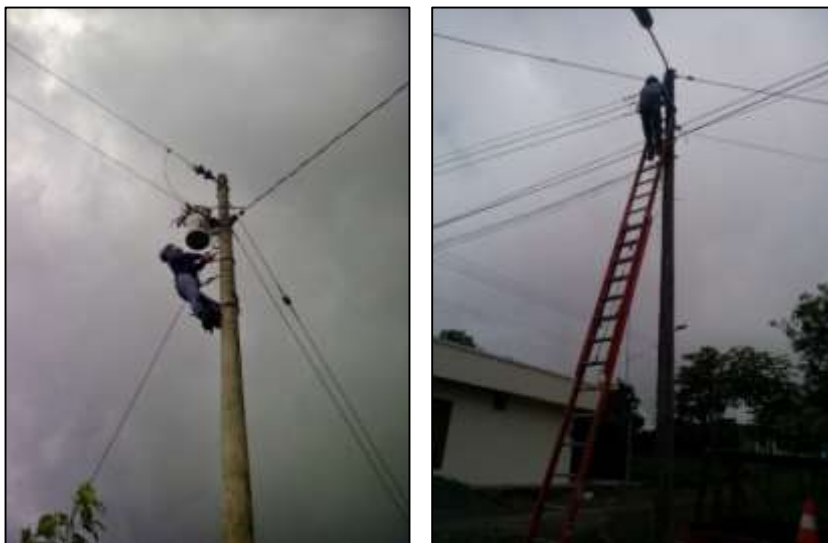
Figura 4.10 Trabajo en altura
