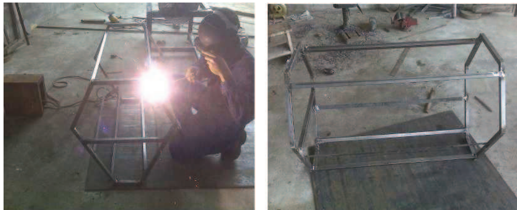
Figura: 6-8 Construcción de armazón
