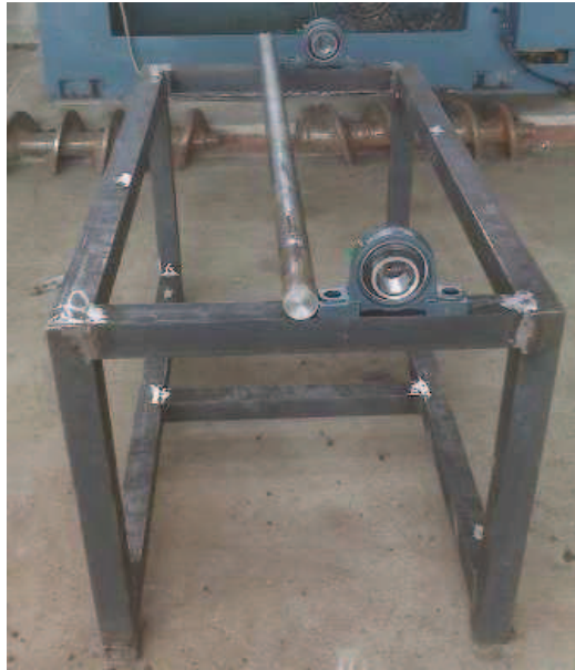
Figura: 6-6 Construcción de la estructura
