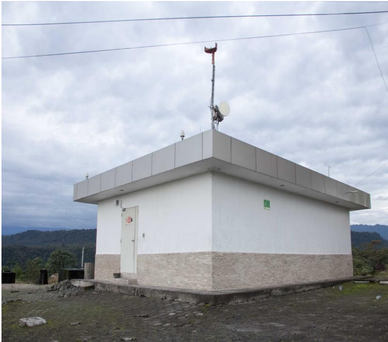
Fotografía 1. Lugar de trabajo de las CTAR, ubicado en Shell Mera Elaborado por el autor
