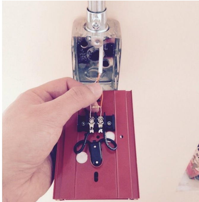
Figura 4.13 Conexión estación manual MIRCOM
