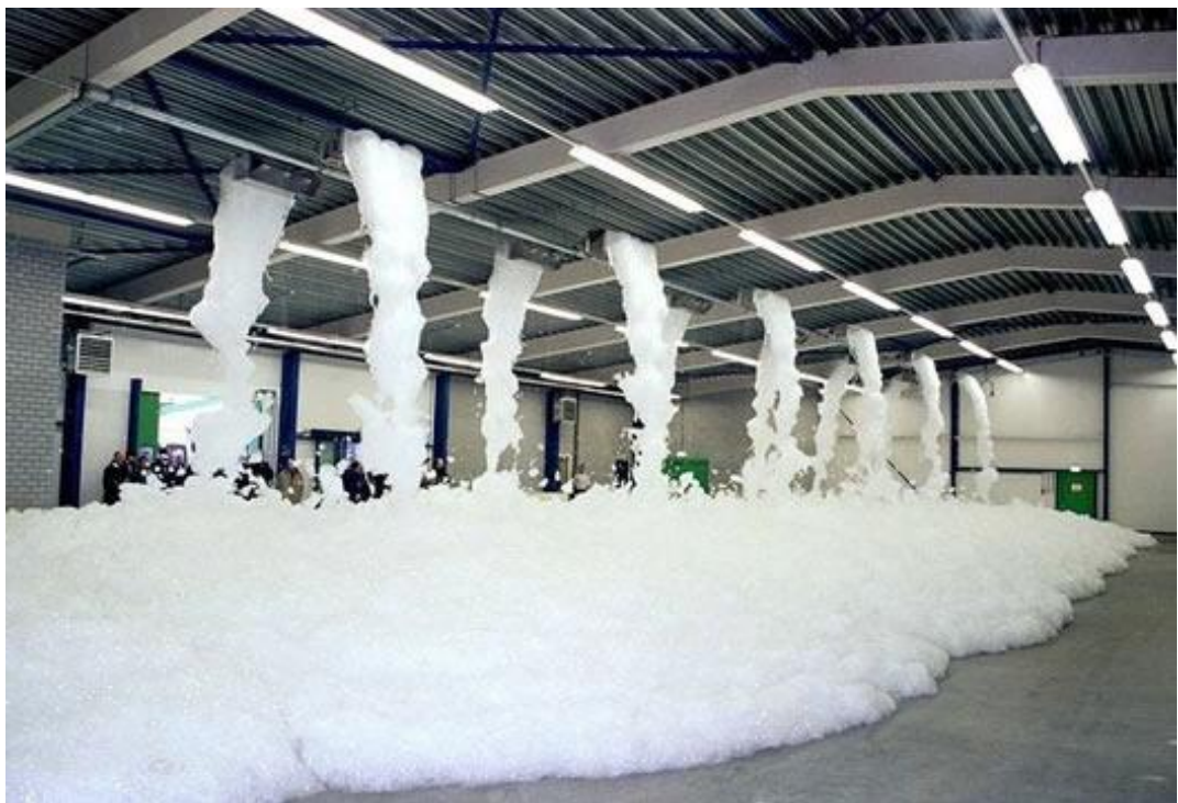
Figura 2.9 Sistema de aspersores a base de espuma
