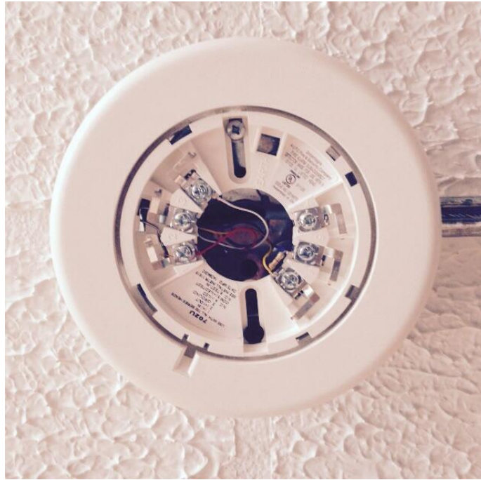
Figura 4.15 Conexión detector de humo 741-UT
