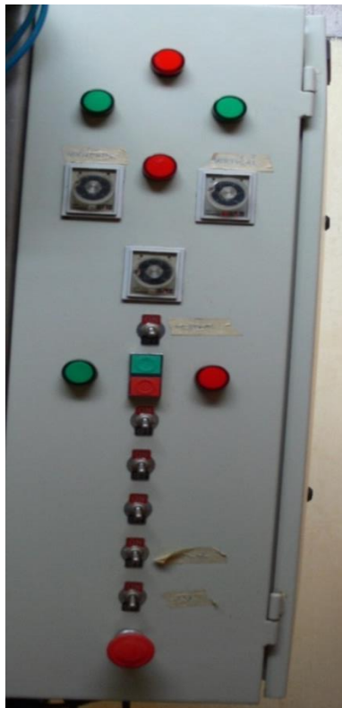
Figura 47. Instalación del tablero de control
