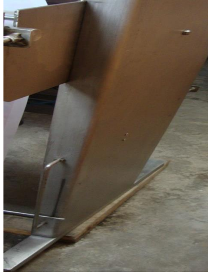
Figura 44. Construcción de la estructura
