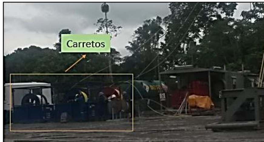
Figura 14. Carretos para líneas hidráulicas y cables de poder.
