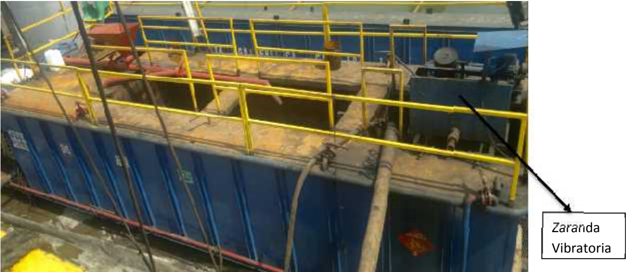
FIGURA 48: Tanque de Lodos.
