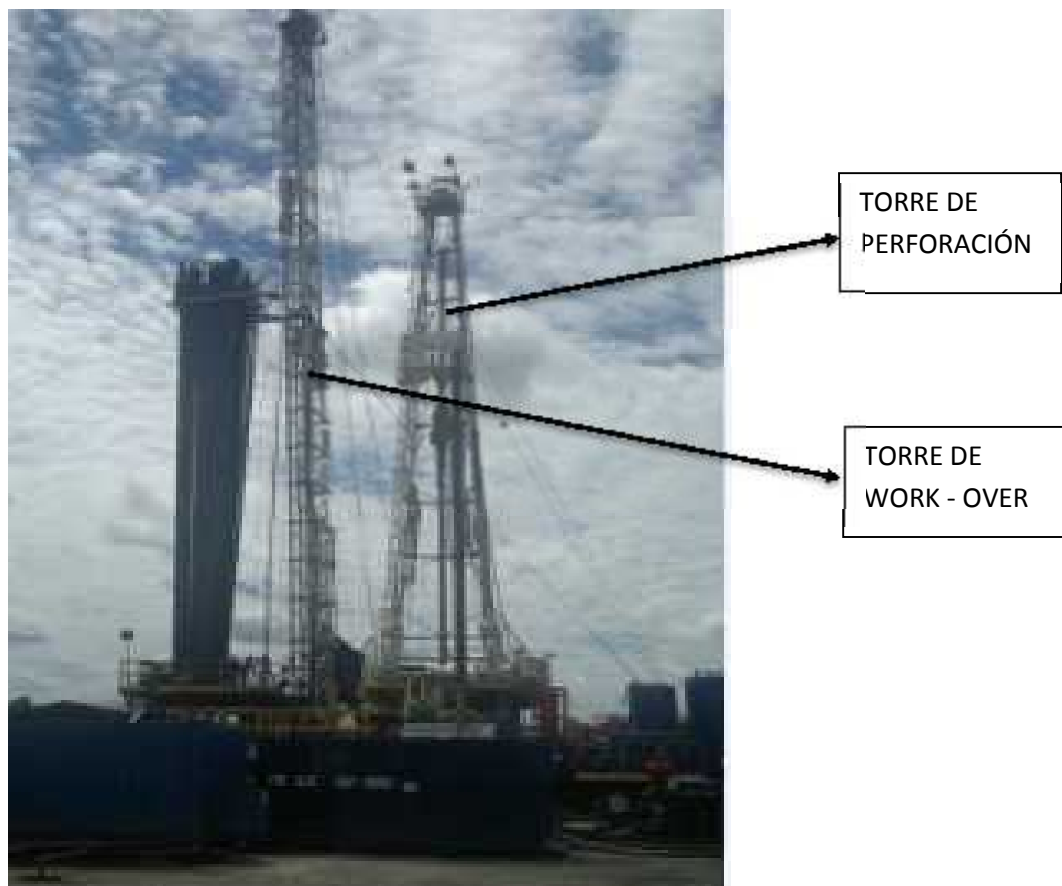
FIGURA 9: Torre de Perforación
