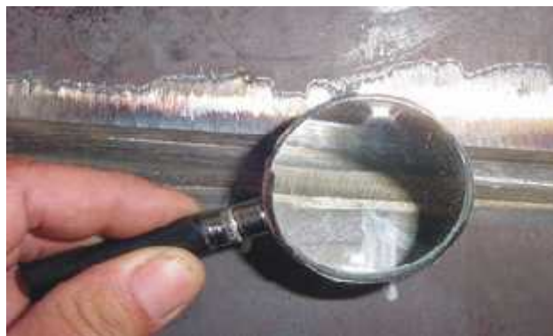
FIGURA 2: Inspección Visual (ITTSA, 2013)
