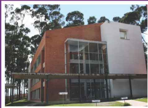
Edificio de la Facultad de Ciencias Sociales y Comunicación
