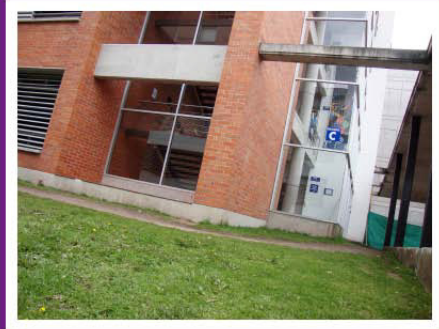
Entrada principal al Bloque C
