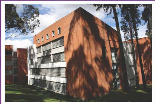
Edificio de la Facultad visto desde el este
