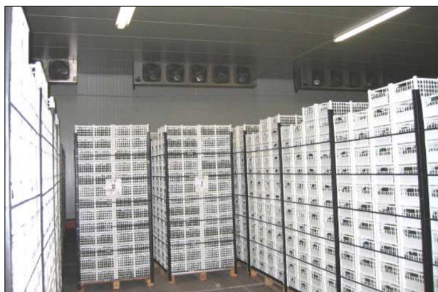
Pallets colocados en cuarto frío para el proceso de pre-enfriado Foto 7. Fuente: www.google.com
