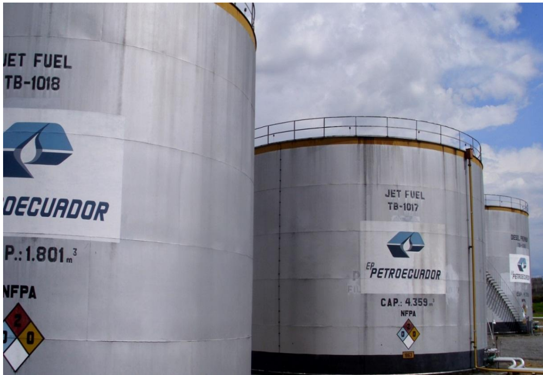
Figura 7: Tanques de almacenamiento Techo fijo de la planta de Jet del terminal Beaterio
