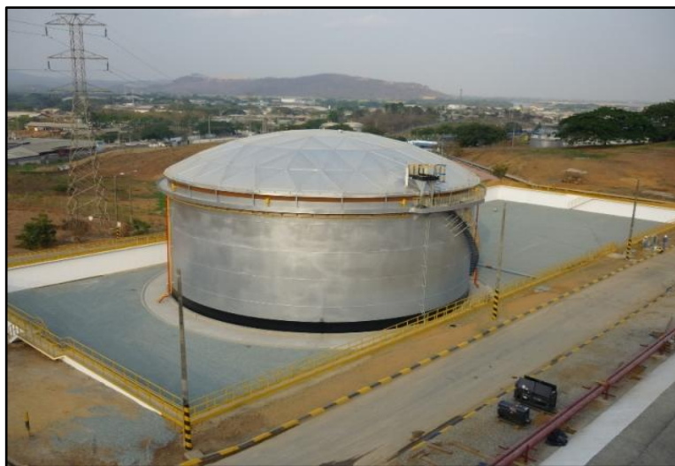
Figura 2.2. Tanque Vertical de Techo Fijo. Fuente. (EP-PETROECUADOR, 2014)
