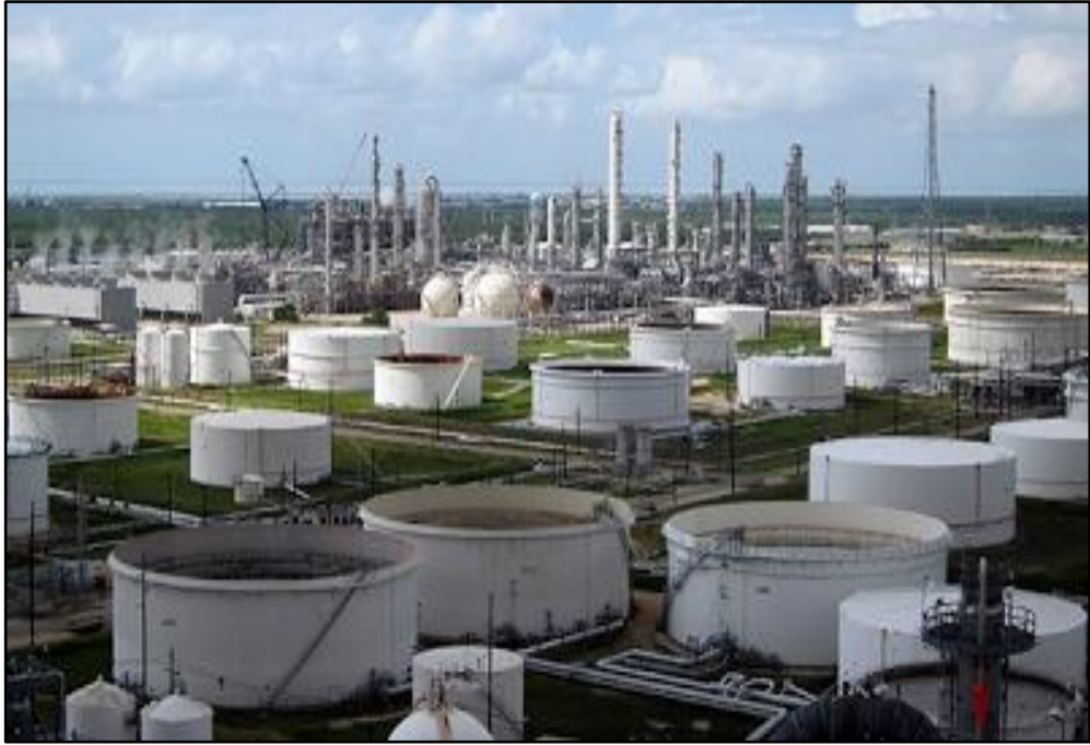
Figura 2.3. Tanques Verticales de Techo Flotante. Fuente. (EP-PETROECUADOR, 2014)
