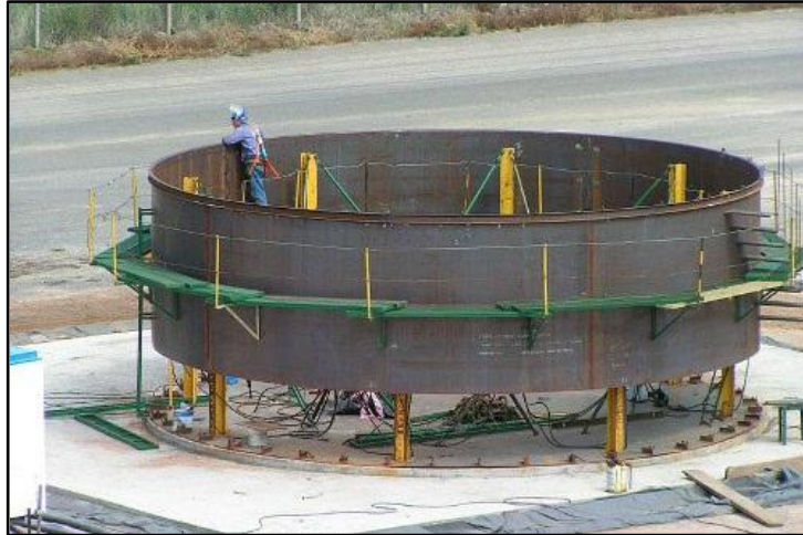
Figura 2.12. Procedimiento de Montaje de un Tanque de Almacenamiento. Fuente. (EP-PETROECUADOR, 2014)
