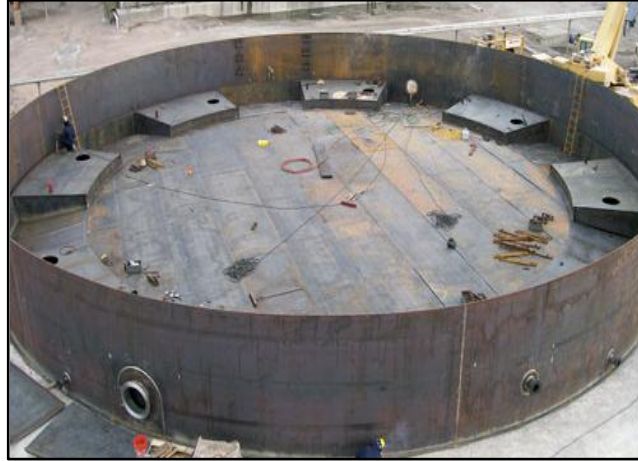
Figura 2.10. Construcción de un Tanque de Almacenamiento. Fuente. (EP-PETROECUADOR, 2014)
