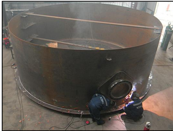
Figura 2.11. Procedimiento de Soldadura de un Tanque de Almacenamiento.
