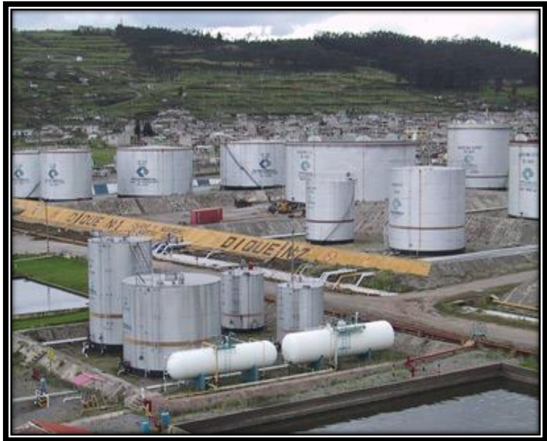
Figura 16. Área de almacenamiento Terminal Beaterio EPPETROECUADOR Fuente: www.google.com
