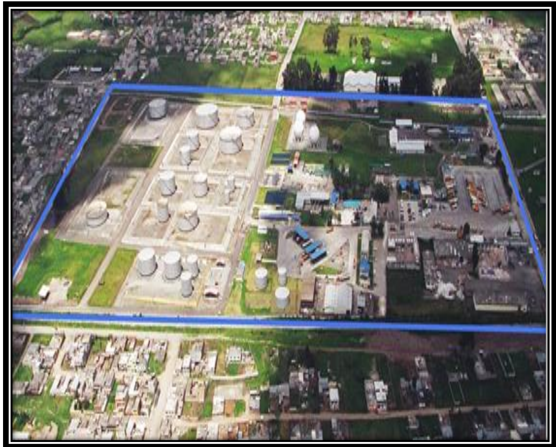
Figura 15. Terminal de productos limpios el Beaterio Fuente: www.google.com
