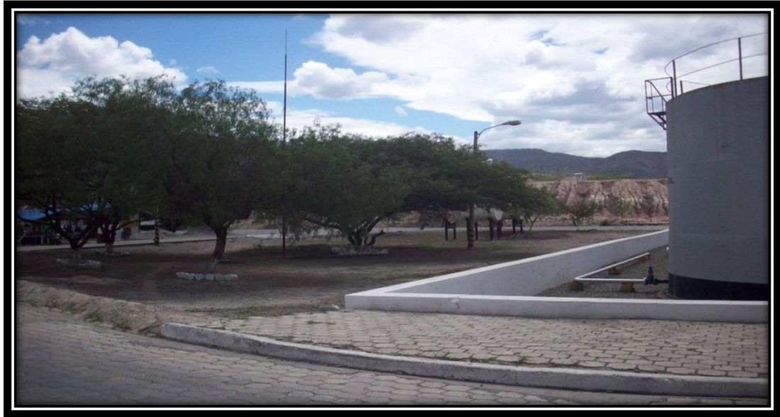
Figura 26. Área posterior a tanques de almacenamiento Fuente: Gómez Edison
