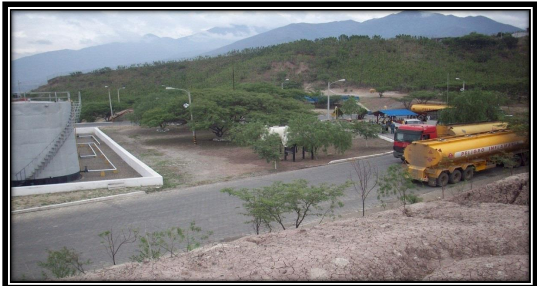
Figura 27. Área posterior a tanques de almacenamiento. Fuente: Gómez Edison
