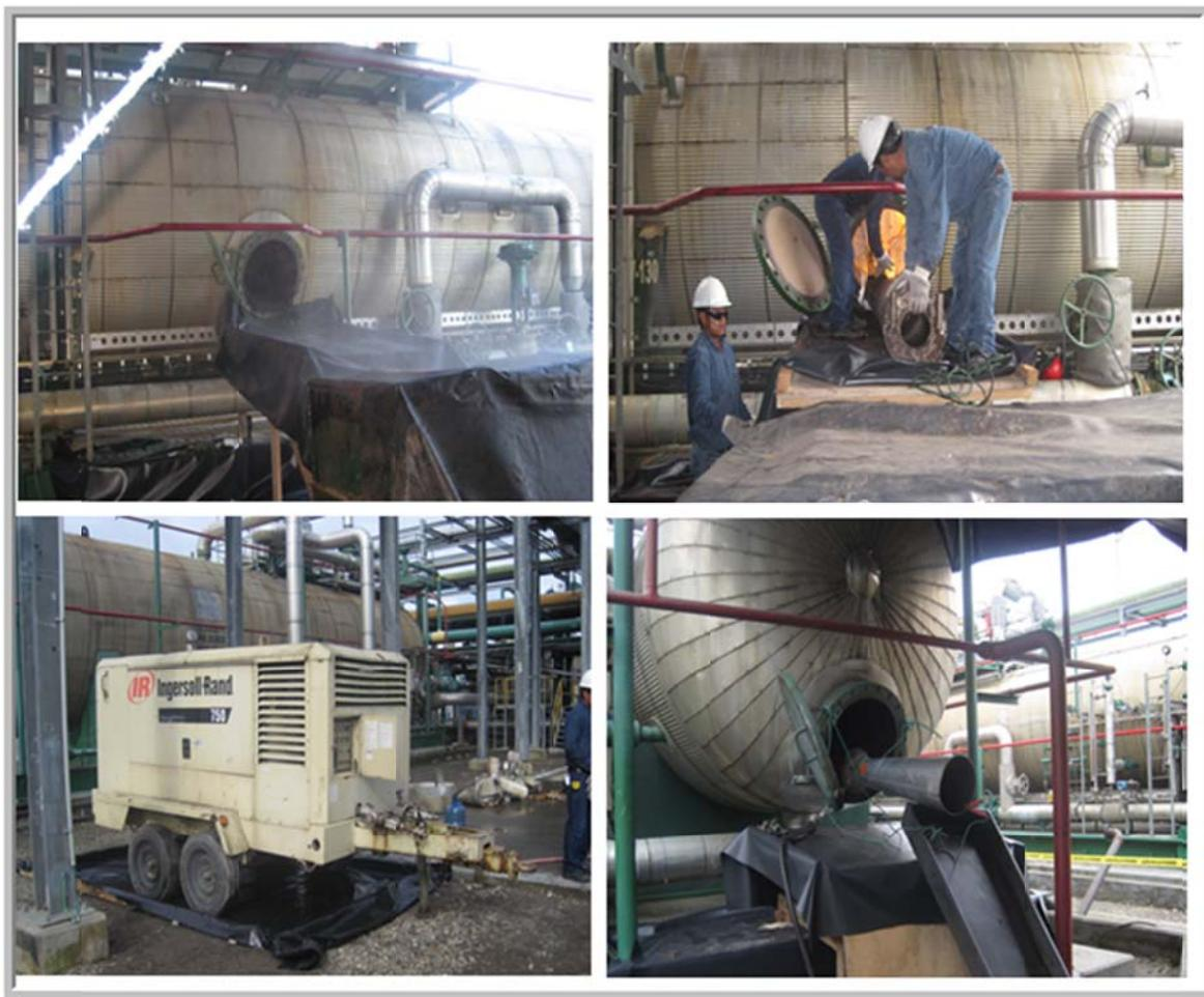
**Figura 32:** Ventilación forzada con compresor portátil
