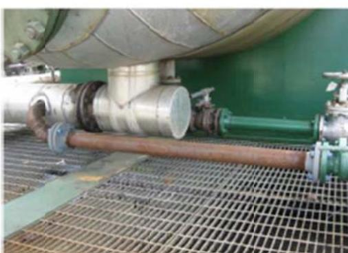
FOTO 3. CORROSIÓN LEVE POR FALTA DE PINTURA
