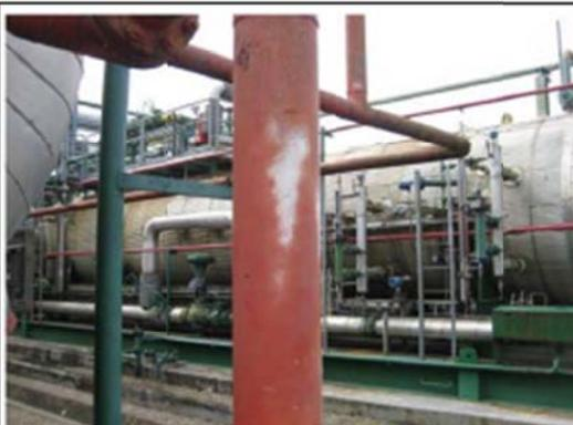
FOTO 2. DECOLORACIÓN DE PINTURA EN TUBERÍAS
