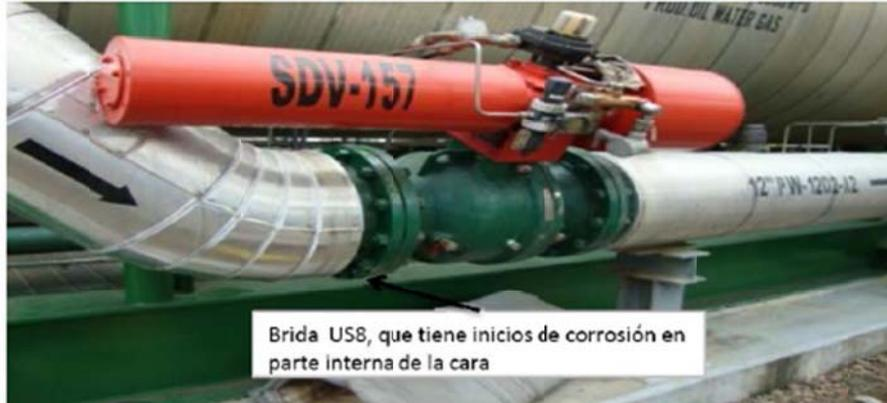
Brida US8, que tiene inicios de corrosión en parte interna de la cara
