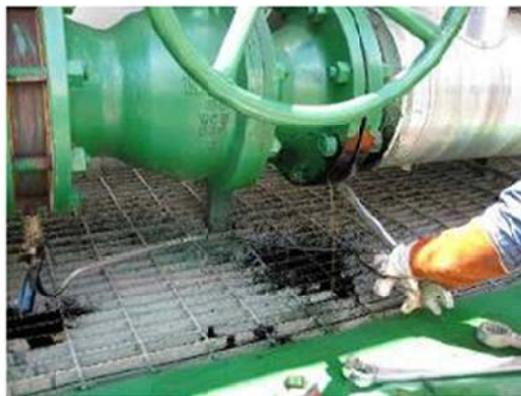
Fotografía No. 1. Fuga Detectada en Octubre de 2009 (V-120).
