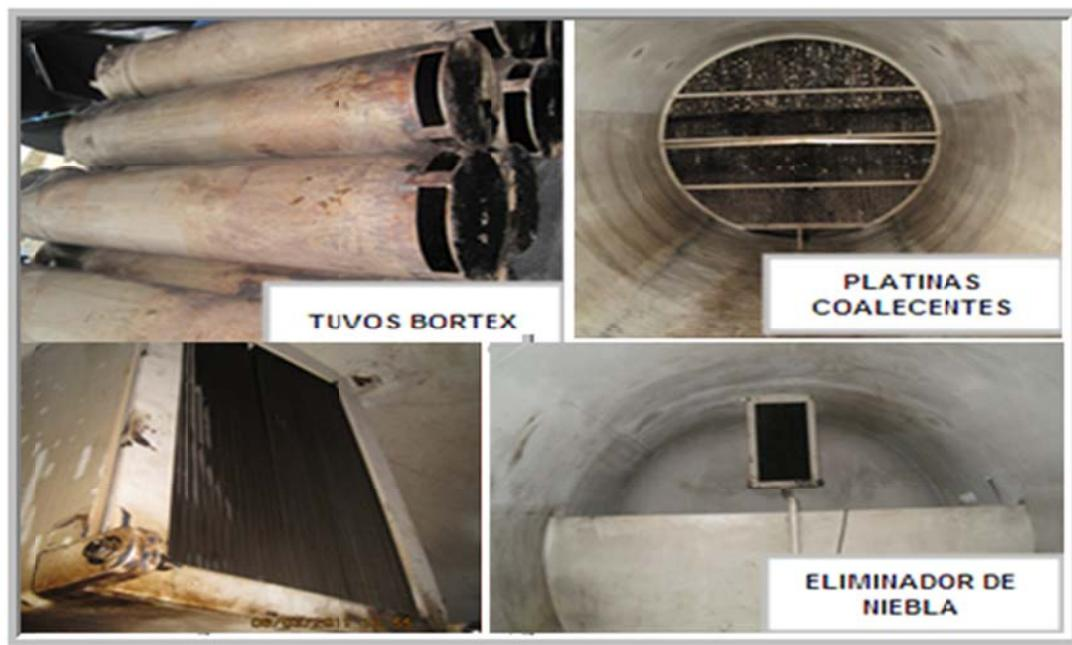
**Figura 39:** Retiro de accesorios internos para mantenimiento
