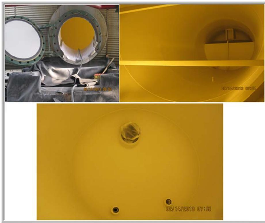
**Figura 50:** Trabajos de pintura y curado al interior del separador
