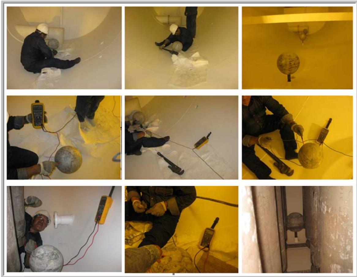
**Figura 51:** Instalación de ánodos de sacrificio y medición de continuidad
