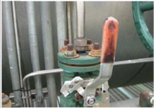
FOTO 3. CORROSION LEVE EN PERNOS
