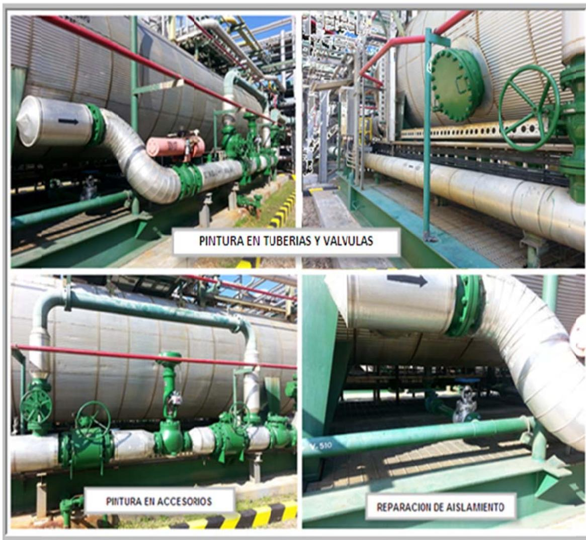
**Figura 55:** Vista general del mantenimiento externo al separador
