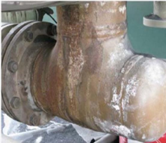
**FOTO 4. PRESENCIA DE CORROSIÓN**
