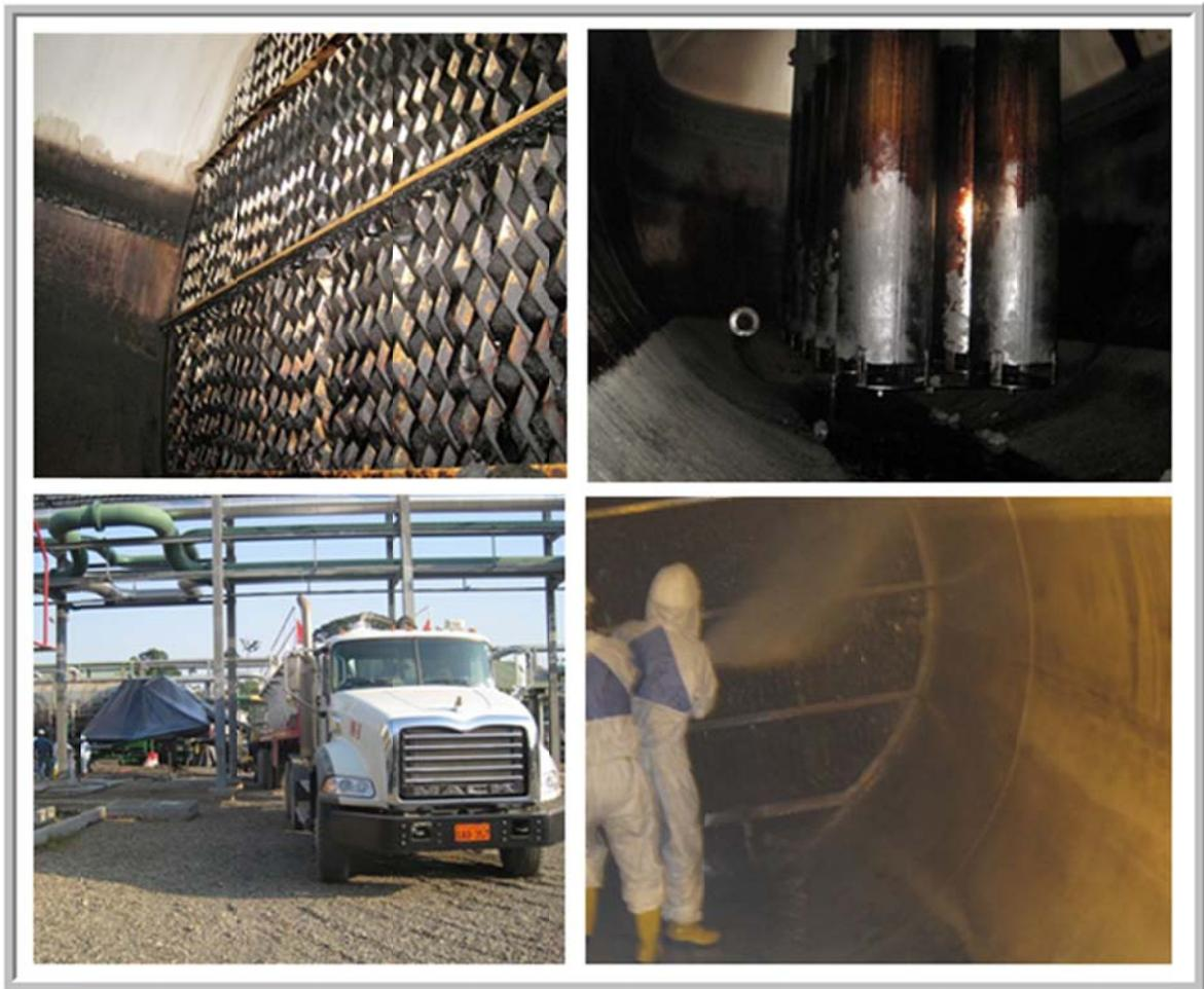
**Figura 35:** Lavado con desengrasante y agua al interior del separador
