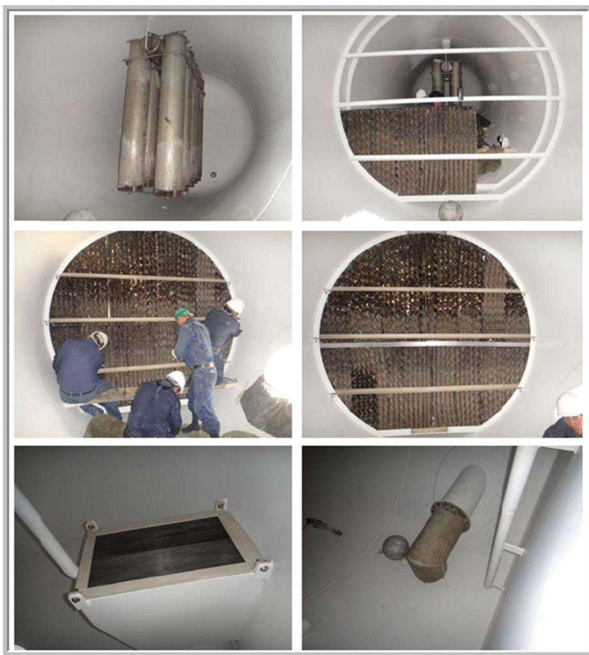
**Figura 53:** Reinstalación de accesorios internos
