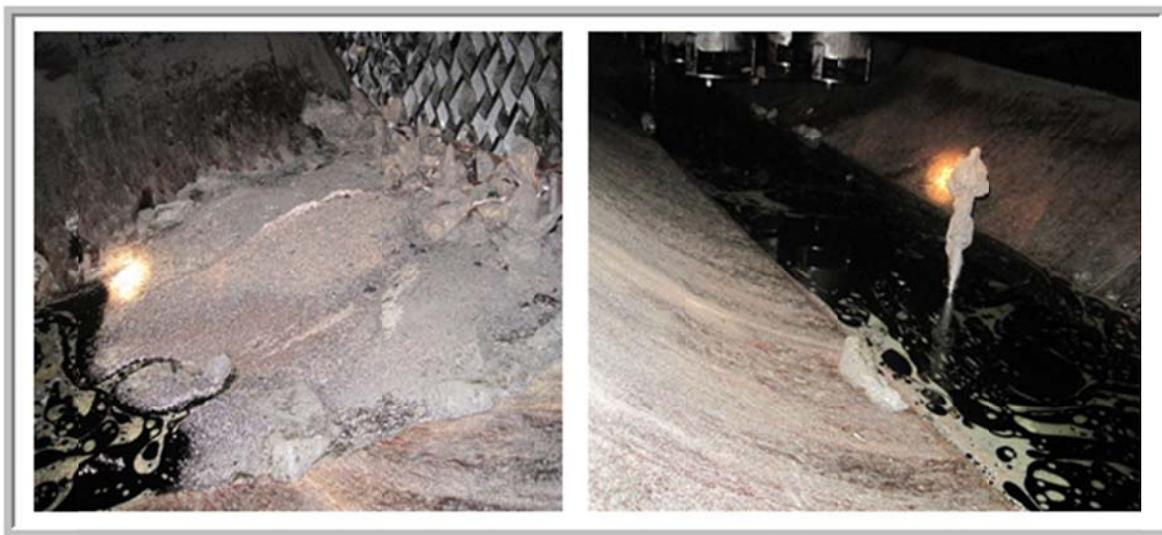
**Figura 31:** Solidos e hidrocarburos al interior del separador
