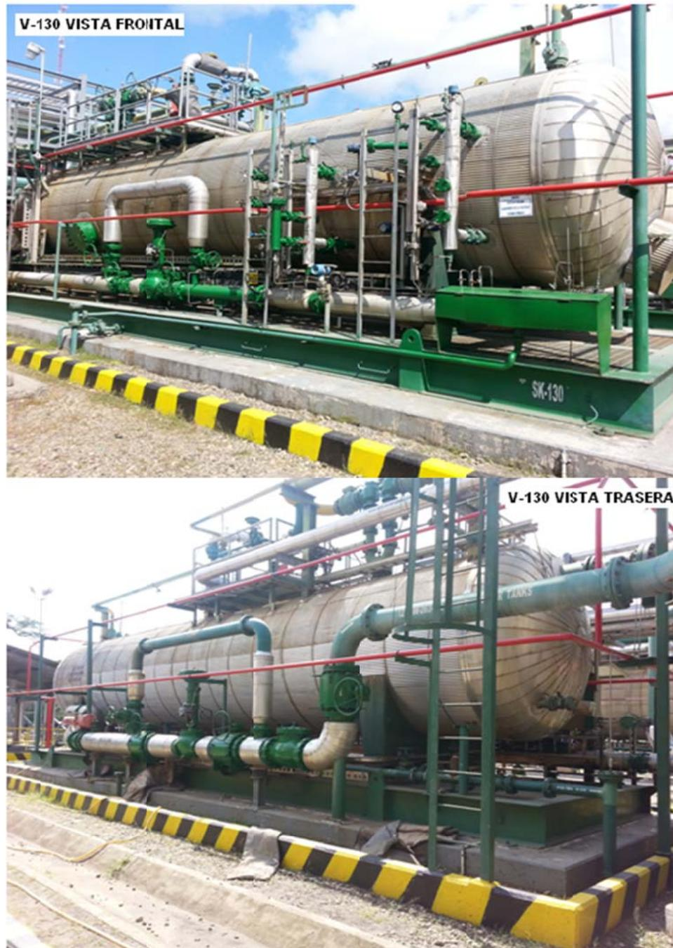
**Figura 26:** Vista frontal y vista trasera del separador V-130
