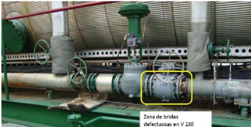
Fotografía No. 8. Bidas Defectuosas detectadas por arreglo de fases en Mayo de 2010 (V-130)
