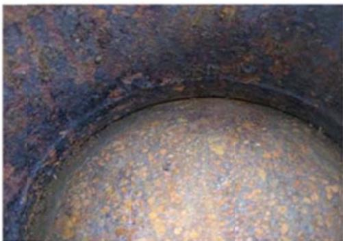
PRESENCIA DE CORROSIÓN EN LA BOLA Y VÁLVULA
