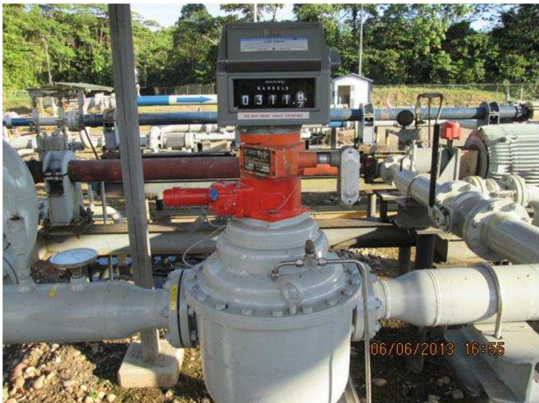
Figura 2.28. Medidor de Petróleo
