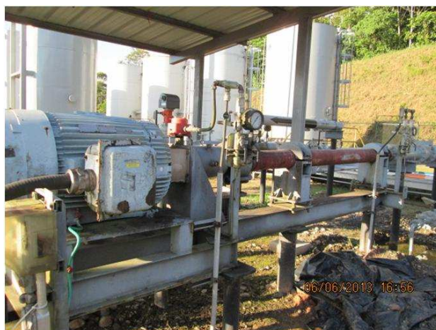
Figura 2.29. Bomba de Transferencia de Crudo
