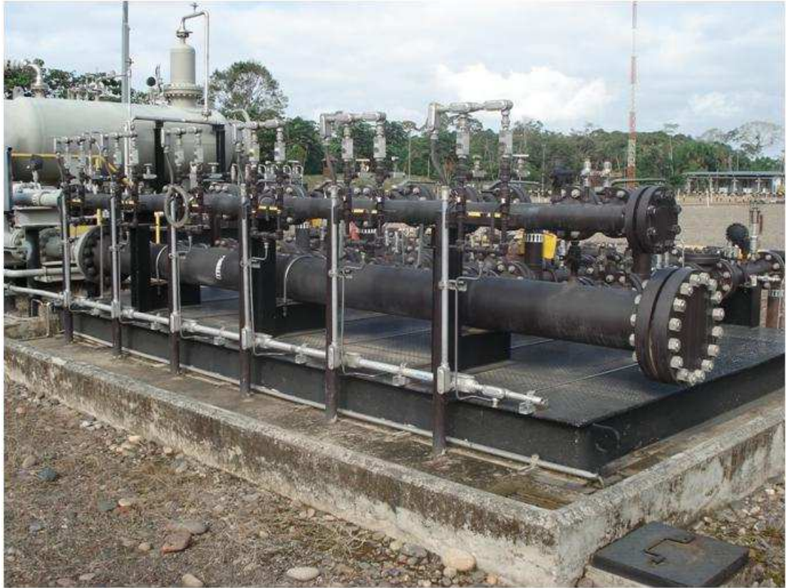
Figura 2.12. Manifold
