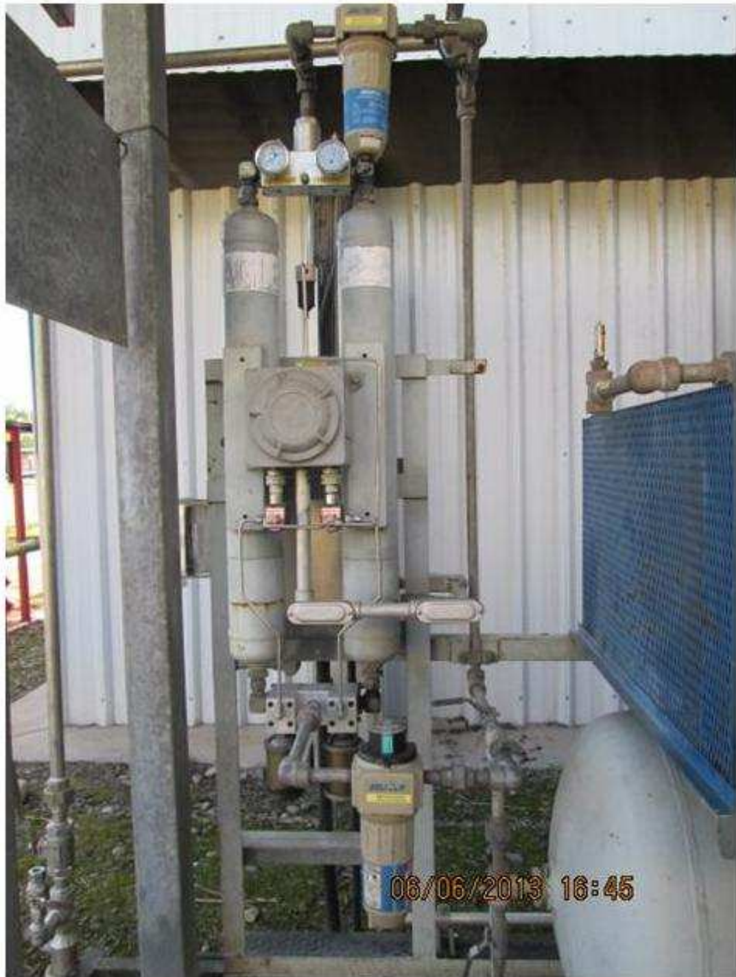
Figura 2.41. Secador de aire para instrumentos
