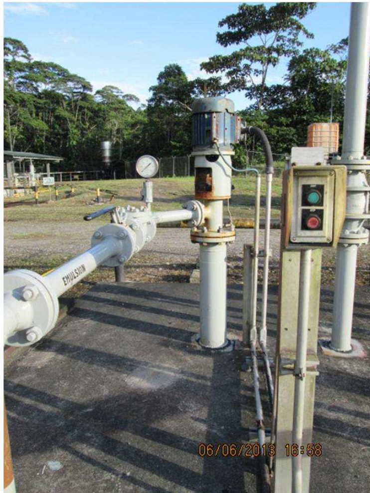
Figura 2.36. Bomba Vertical del Sumidero
