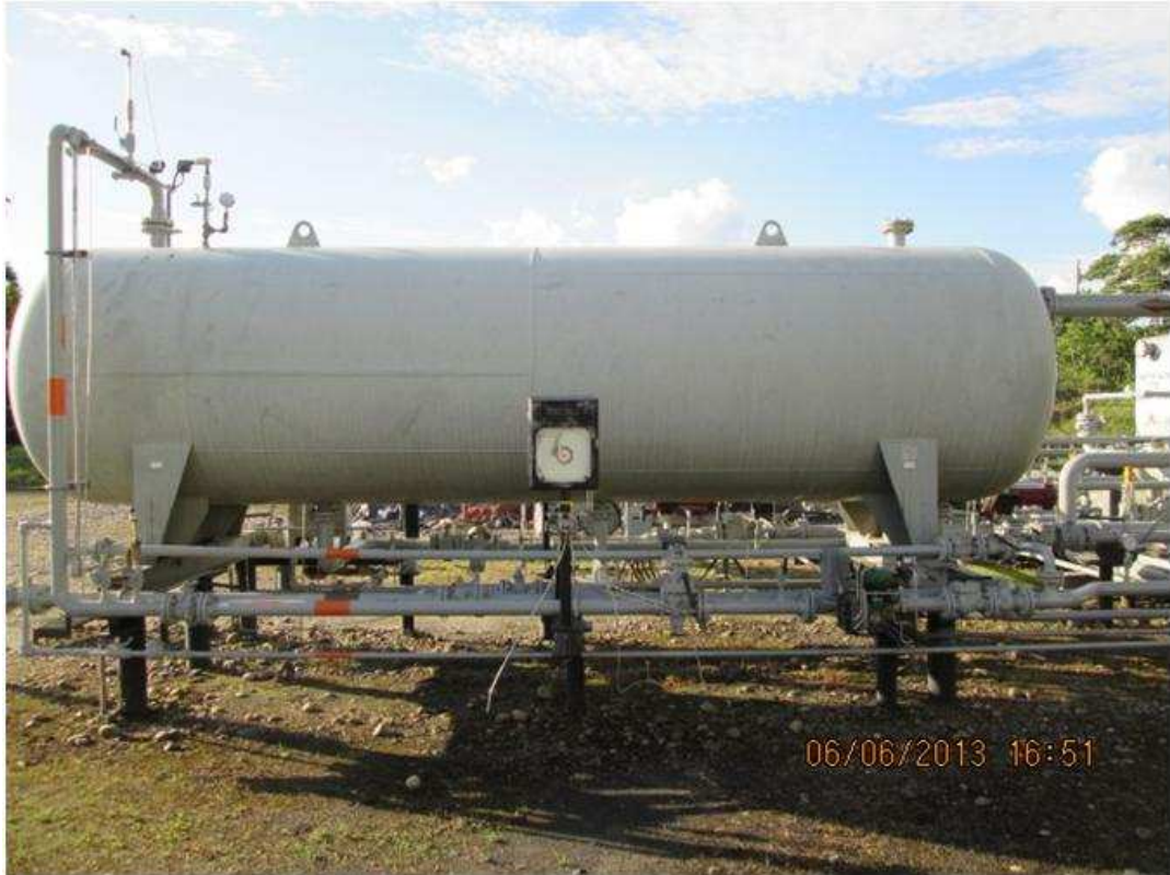
Figura 2.19. Separador de Producción
