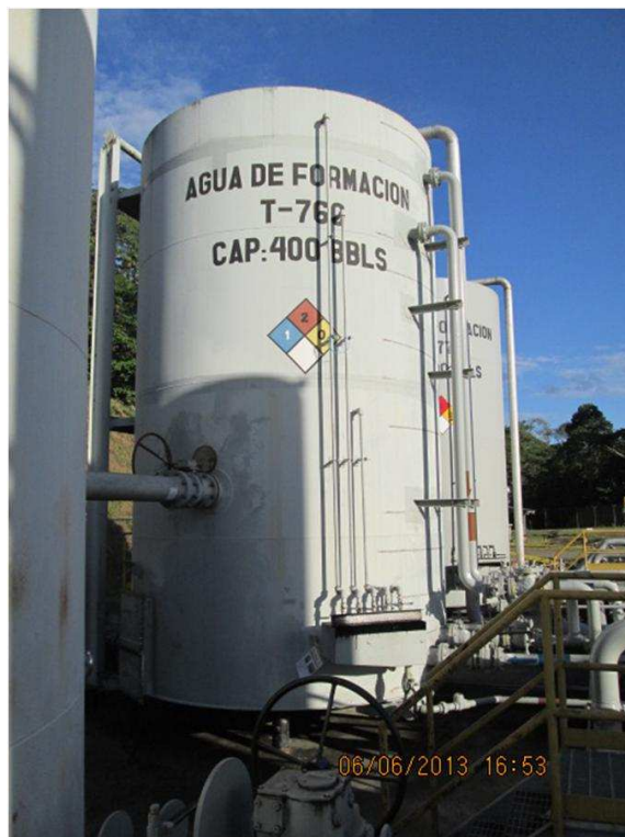
Figura 2.30. Tanque de Desnatado (Skimmer)
