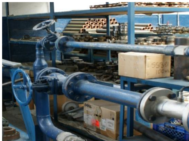
Figura 62: Válvula para control de flujo según el tipo de bomba
