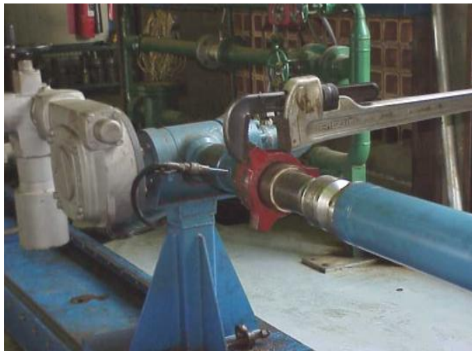
Figura 60: Bomba lista para el ensayo
