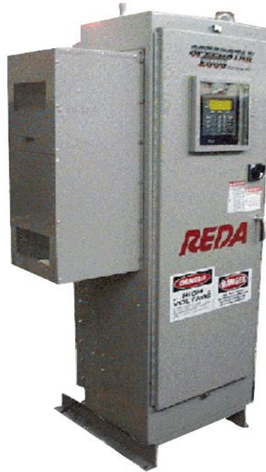
FIGURA 2.6 VARIADOR DE FRECUENCIA.
